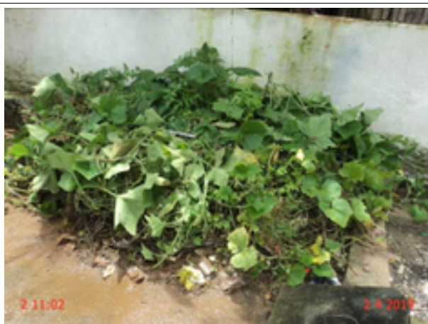
Foto 26 – ETE Alho – acúmulo de lixo no leito de secagem.
