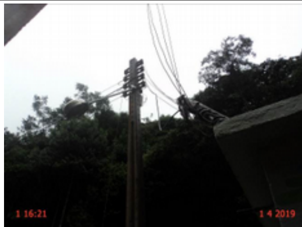
Foto 11 – Captação: instalações elétricas inadequadas no poço PT-13.
