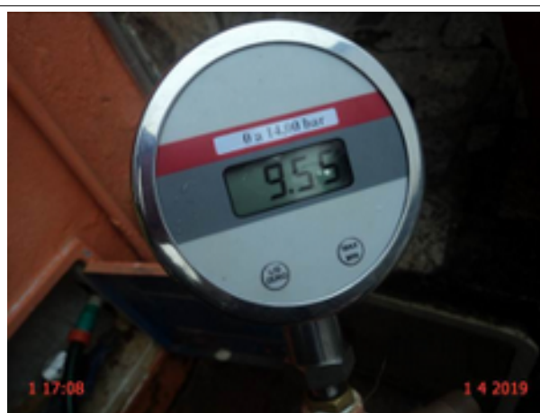
Foto 2 – RDA: medição de pressão instantânea no endereço Rua José Marinho Goes, nº 680.
