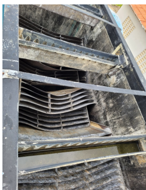
Foto 5 - ETA: Decantador desativado.
