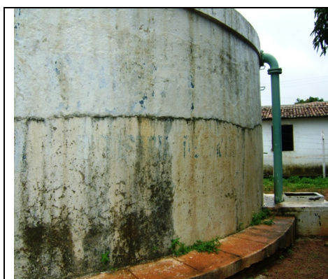
Fotos 32 e 33 – Sinais de vazamentos e extravasamentos no RAP-01
