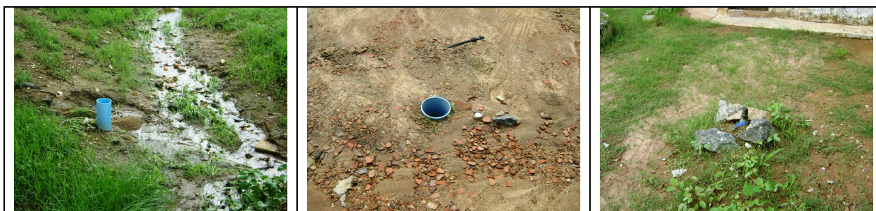
Fotos 41 e 42 – Registros de descarga nas Ruas Major Adelino, Rafael C. Araujo e Major Sales
