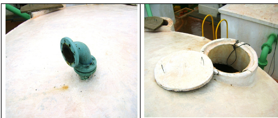
Fotos 26 e 27 – Detalhes da laje superior do RSE-01
