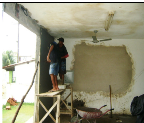
Foto 44 – Escritório em reforma
