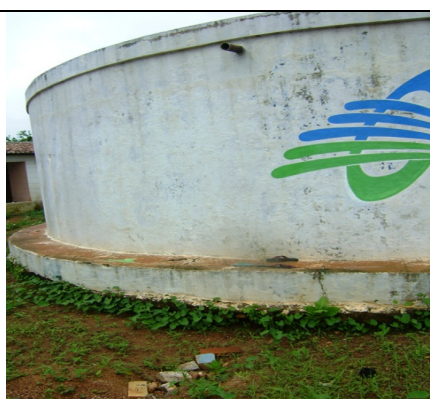
Fotos 32 e 33 – Sinais de vazamentos e extravasamentos no RAP-01
