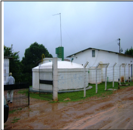
Foto 3 – Vista da entrada da ETA do SAA de Umirim
