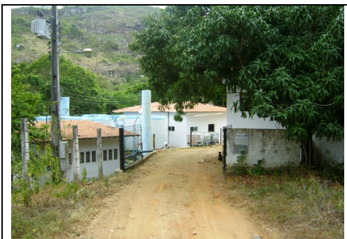
Foto 3 – Vista da entrada da ETA do SAA de Redenção
