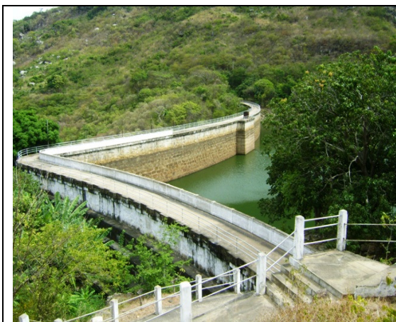
Foto 1 – Vista parcial da Açude Acarape do Meio
