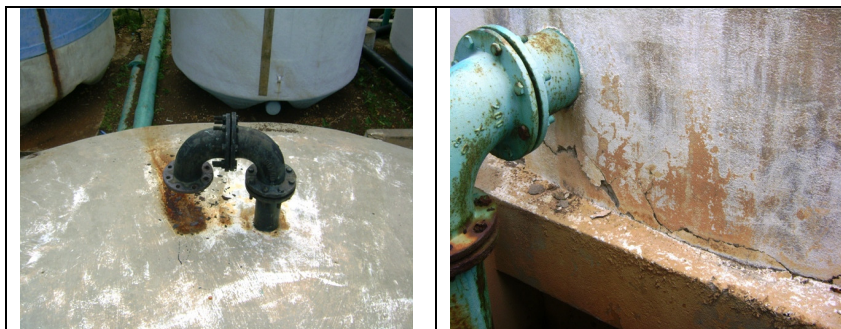
Foto 36 – RSE-01 - Tubulação de ventilação
