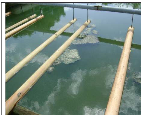
Foto 11 – Material sobrenadante no decantador
