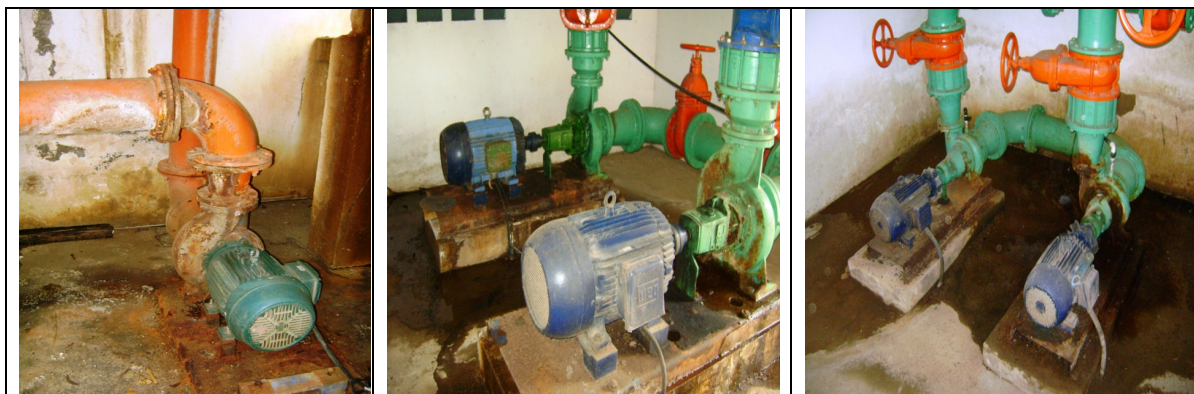
Fotos 29, 30 e 31 - EEAT-01, EEAT-02 e EELF-01 - detalhes dos conjuntos motores-bomba
