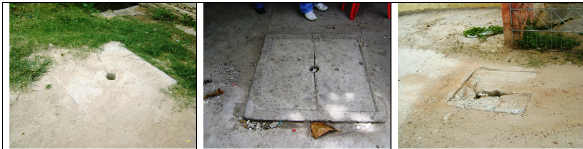
Fotos 43, 44 e 45 – Registros de descarga vistoriados nas Ruas Senhor do Bonfim, Lurdugero Guilherme e Marechal Deodoro
