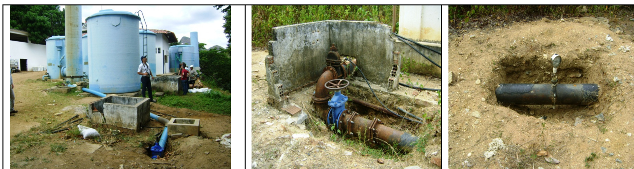
Fotos 4,5 e 6 – Vistas parciais da ETA
