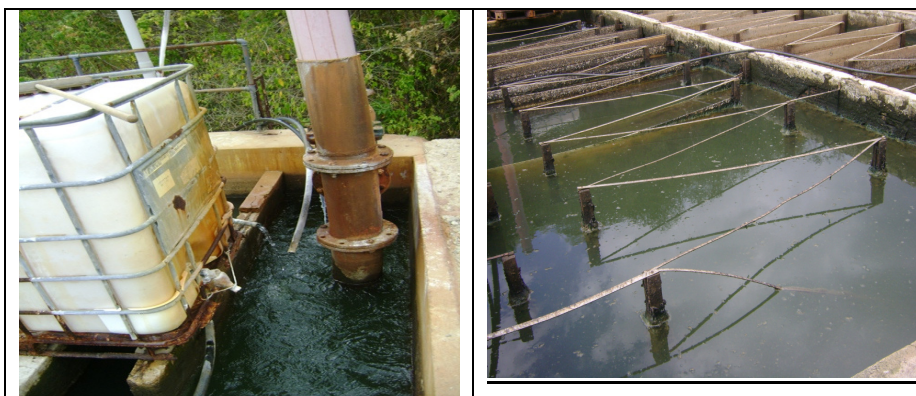
Foto 9 – Aplicação de produtos químicos no decantador
