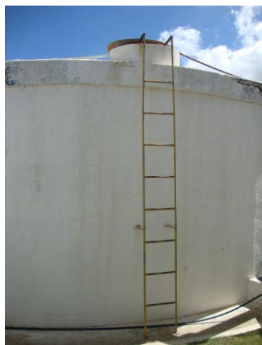
Foto 59 – RAP-01 com escada de acesso.
