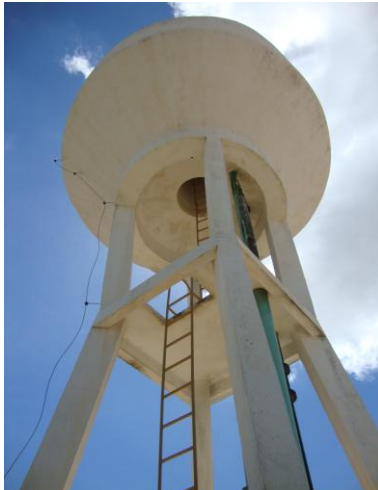
Foto 72 – REL-02 com escada de acesso.
