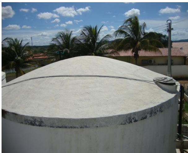
Foto 60 – Cobertura do RAP-01.
