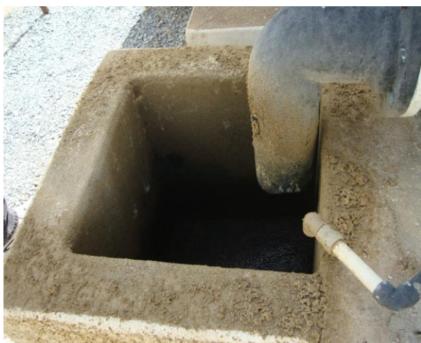
Foto 21 – Lavagem do filtro-02.
