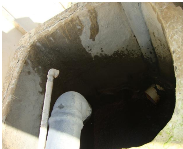
Foto 20 – Lavagem do filtro-01.
