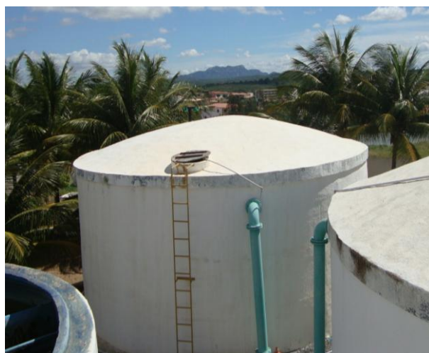
Foto 65 – Cobertura do RAP-02.
