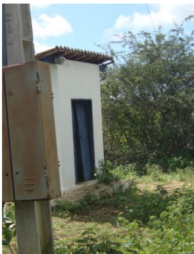
Foto 5 – Casa de abrigo do QC da EECS-01.
