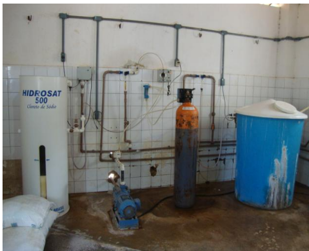
Foto 25 – Vista da fábrica de cloro.
