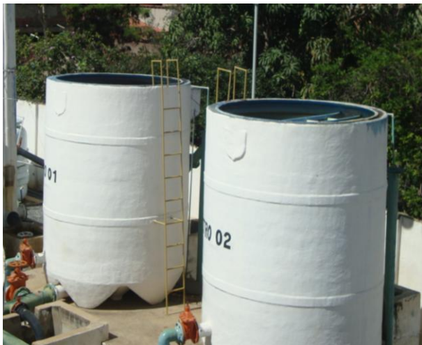
Foto 15 – Vista superior dos filtros.
