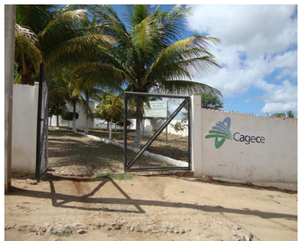
Foto 12 – Vista externa da ETA.
