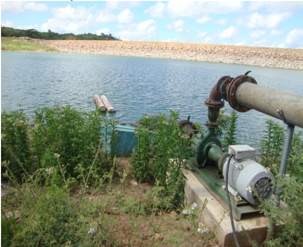
Foto 3 – Vista da captação no Açude Monsehor Tabosa.
