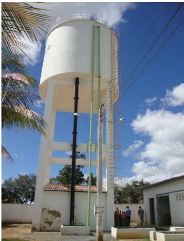
Foto 68 – Vista do REL-01 com escada de acesso.
