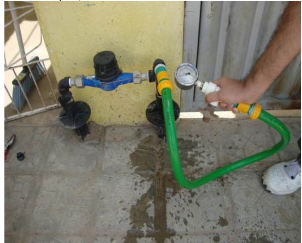
Foto 81 – Medição de pressão instantânea na Rua Hemógenes Marques de Pinto, nº 22 – Jucás.
