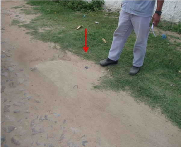
Foto 84 – Registro de descarga na Av. Pessoa Pires.
