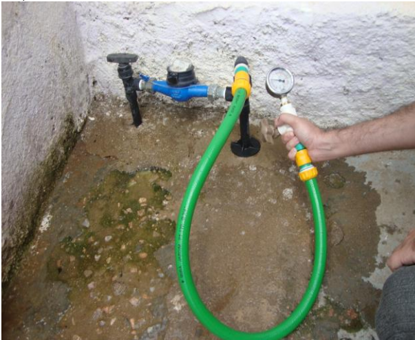
Foto 80 – Medição de pressão instantânea na Rua 20 de Janeiro, nº 105 – Centro.
