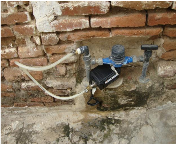
Foto 82 – Medição de pressão com instalação às 9:30h do dia 25/06/13 e retirada às 9:30h do dia 26/06/13, com aparelho datalogger na Rua Tenente Anastácio, nº 12 - Trizidela.
