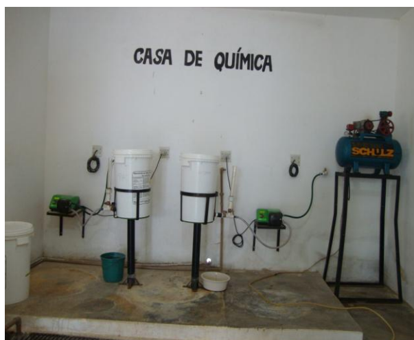
Foto 24 – Vista interna da casa de química.
