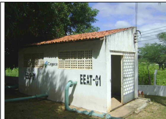
Foto 34 – Vista da EEAT-01.
