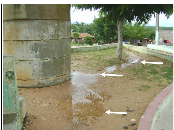
Foto 52 – REL-02: Água oriunda do extravasamento.
