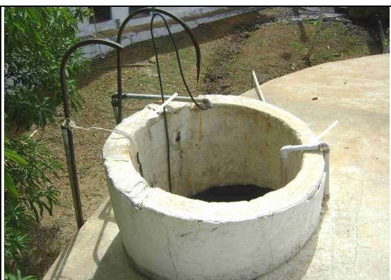
Foto 43 – RAP-01: Escada externa de acesso sem fixação na parte superior e deteriorada pela corrosão.
