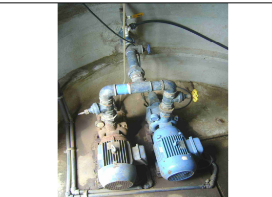
Foto 39 – Vista da EEAT-02.
