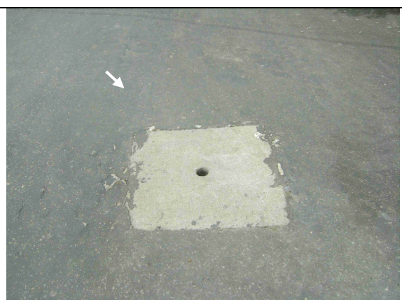
Foto 54 – Registro de descarga localizado na Rua Manoel Jerônimo com a Rua Raimundo Nonato Albuquerque.
