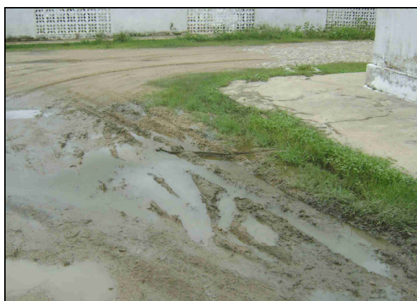
Foto 57 – Registro de descarga soterrado, localizado na Rua Raimundo Nonato Maciel.
