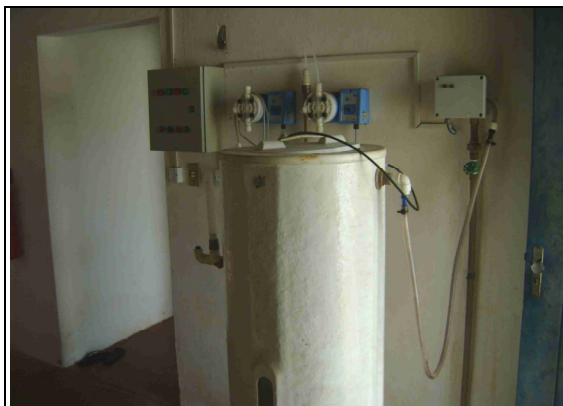
Foto 24 – Sistema de fluoretação sem operação.
