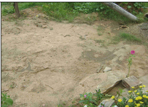
Foto 60 – Registro de descarga soterrado, localizado na Rua SDO.
