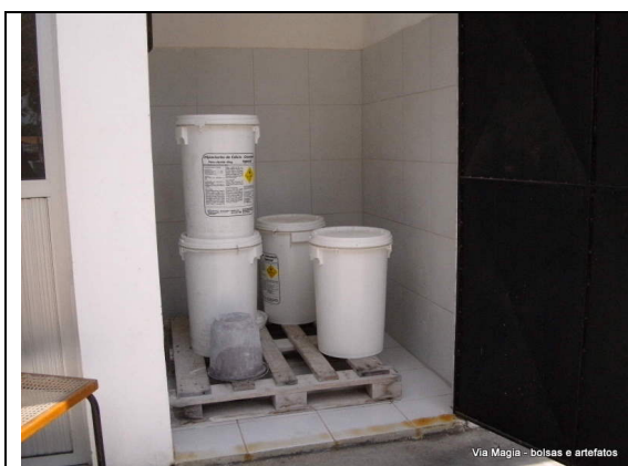
Foto 19 – Armazenamento adequado de produtos químicos.
