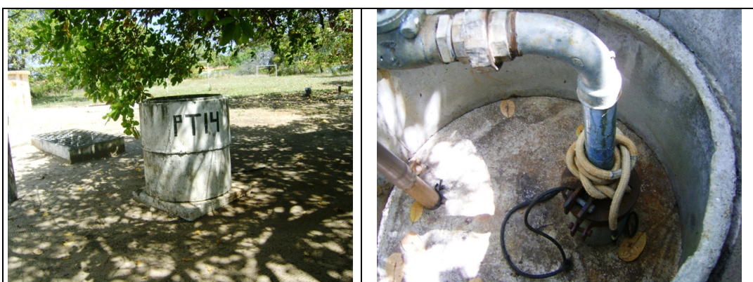
Fotos 10 e 11 – Vistas do PT-14.
