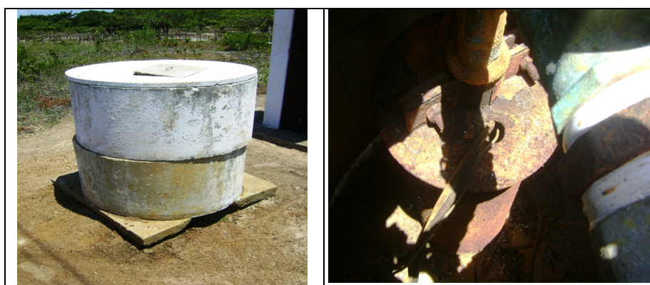
Fotos 12 e 13 – Vistas do PT-15.
