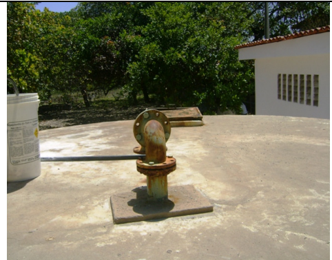
Foto 55 – Vista da laje superior do RAP-02.
