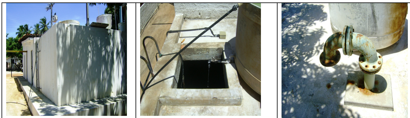
Fotos 50, 51 e 52 - Vistas frontal e superior do RAP-01.
