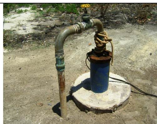
Foto 7 – Vista do PT-12.
