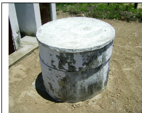
Foto 6 – Vista do PT-11.
