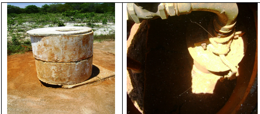
Fotos 14 e 15 – Vistas do PT-17.
