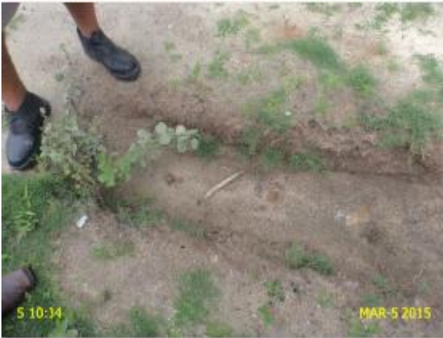
Foto 3 - RDA: registro de descarga sem caixa na Rua do Canal.
