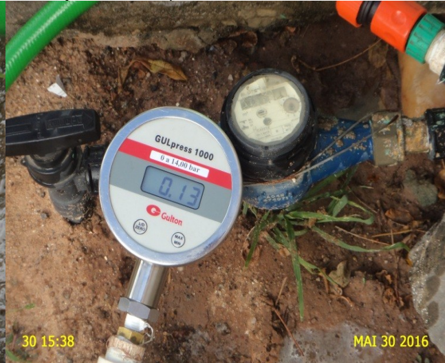
Foto 6 – RDA: Medição de pressão instantânea na rede de distribuição - Rodovia CE 354, SMSB 78 – Córrego.
