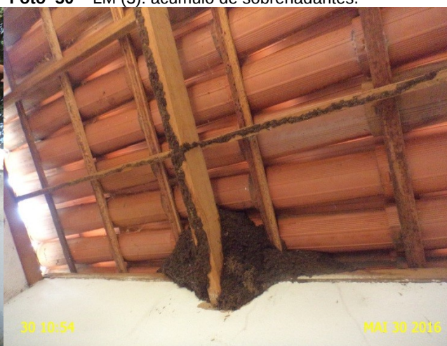
Foto 32 - EERD-05: Presença de cupins no telhado da casa de abrigo do quadro de comando.
