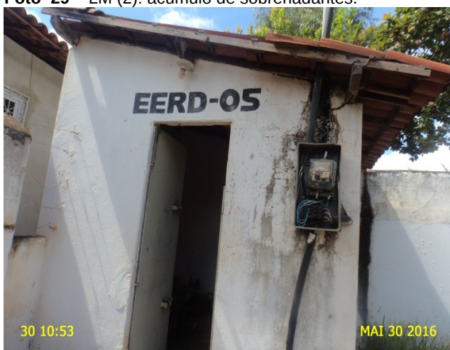
Foto 31 - EERD-05: Pintura da casa de abrigo do quadro de comando deteriorada.
