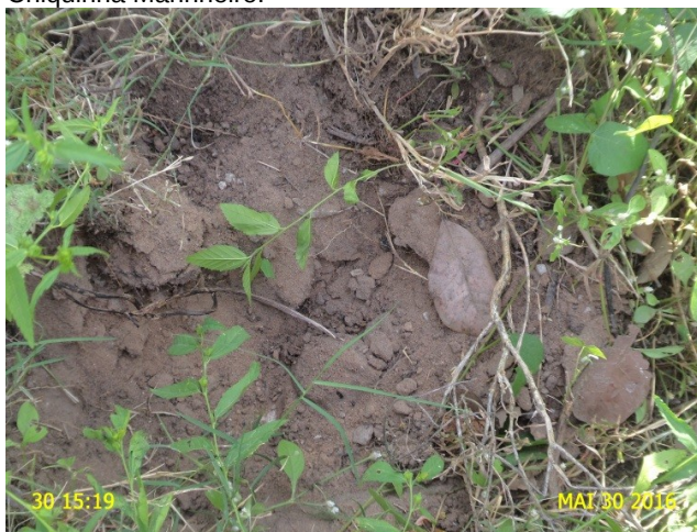
Foto 13 – RDA: Registro de descarga soterrado – Localidade de Córrego.
