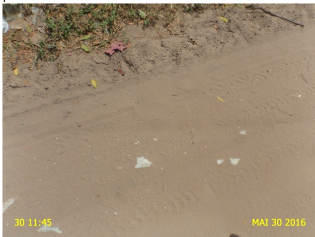
Foto 11 – RDA: Registro de descarga soterrado – Rua Chiquinha Marinheiro.
