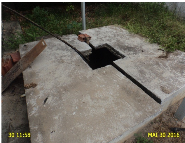
Foto 27 - EEE-01: tampa do poço de sucção sem vedação adequada.
