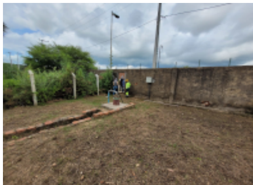
Foto 11 - PT-09: Iluminação inadequada.
