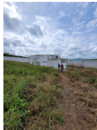
Foto 19 - RAP-03: Necessidade de limpeza na área.
