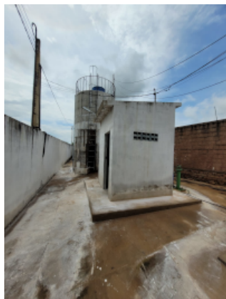
Foto 12 - PT-07/EEAT-02/RAP-05: Iluminação inadequada.
