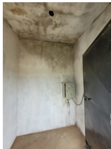
Foto 7 - PT-08: Iluminação inadequada.
