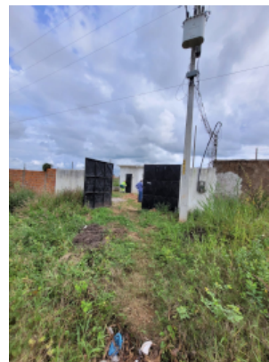
Foto 29 - PT-08: Identificação sem visibilidade.
