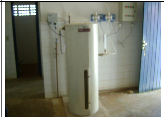
Foto 17 – Sistema de fluoretação.
