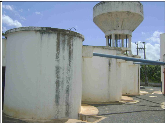
Foto 4 – Outra Vista da ETA.
