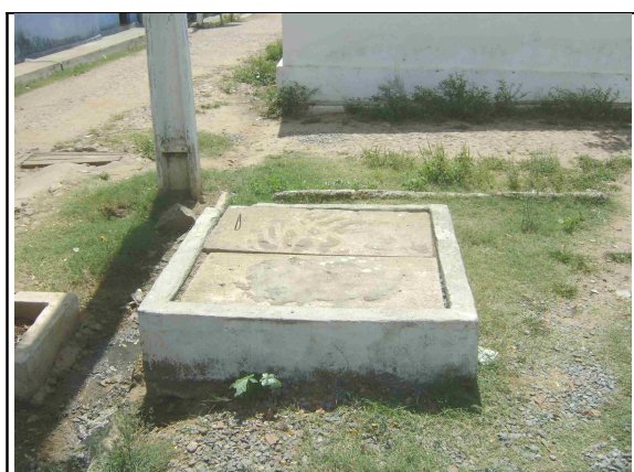
Foto 35 – Registro de descarga localizado na Rua Antônio Leocádio.
