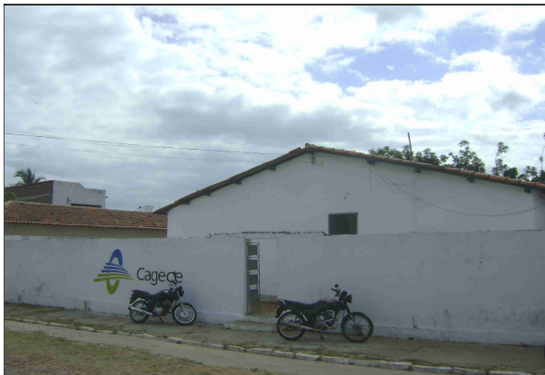
Foto 36 – Vista externa do escritório da CAGECE.
