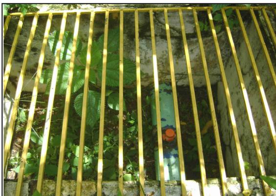
**Foto 28** – Caixa de proteção da estação pitométrica, localizada na saída da EEAT-01.
