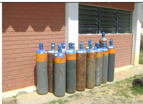
**Foto 24** – Acondicionamento dos cilindros de cloro gasoso sem proteção e exposto ao sol.
