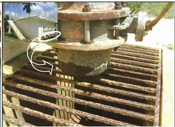
**Foto 14** – ETA: Vazamento no registro de lavagem do Filtro 4.
