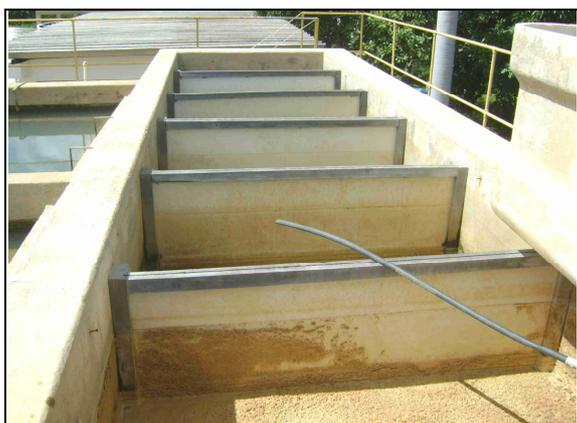
**Fotos 11** – ETA: floculador de fluxo horizontal com chicanas.
