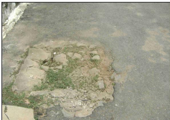
**Foto 43** – Registro de descarga com tampa da caixa de proteção danificada, localizado na Rua Benedita C. Cavalcante.
