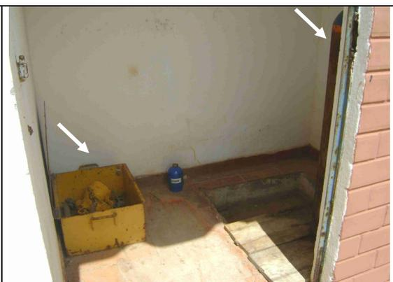
**Foto 22** – Kit de emergência do cloro gasoso próximo ao cilindro de cloro que estava sendo utilizado.
