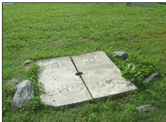
**Foto 30** – Ventosa da AAB localizada entre a captação e a ETA.
