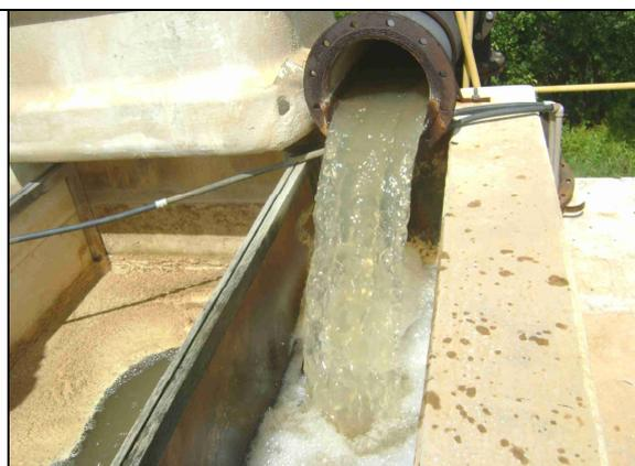
**Foto 10** – ETA: entrada de água bruta na unidade de floculação.
