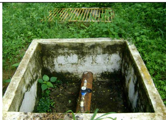
**Foto 27** – Medidor proporcional sem tampa de proteção, localizado na saída da EEAT-01.
