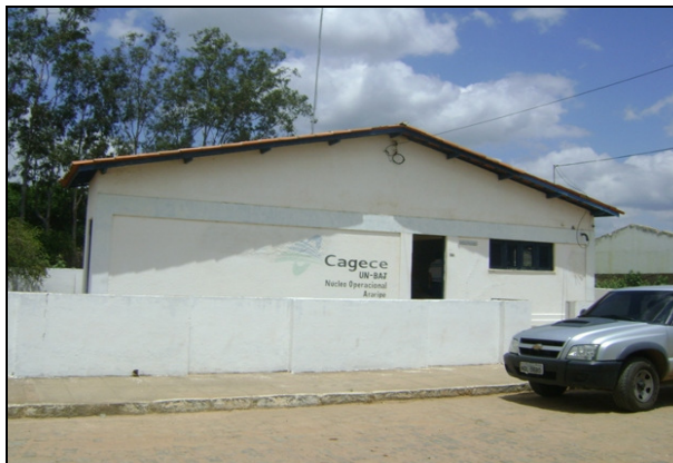
Foto 61 – Vista externa do escritório da CAGECE.
