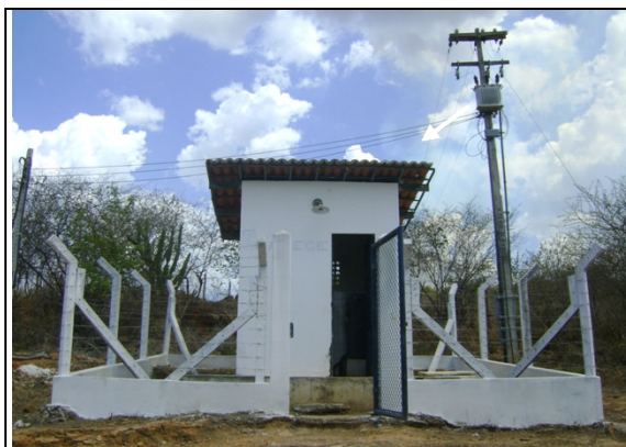
Foto 22 – EECS-01: Sem identificação.
