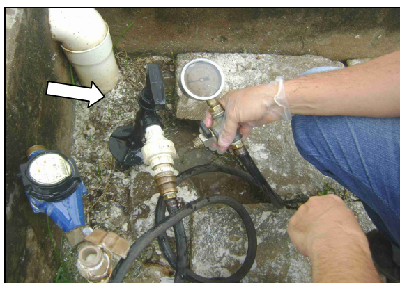
Foto 60 – Medição de pressão na Rua Antônio Nunes, nº 562 - Centro, antes do hidrômetro.
