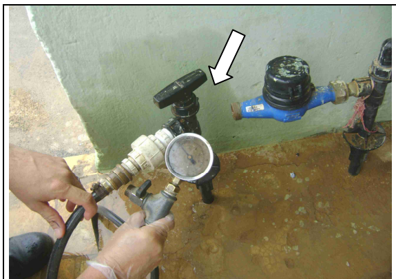
Foto 58 – Medição de pressão na Av. Vicente Alencar Barbosa, nº 31 - Bairro Sipauba, antes do hidrômetro.
