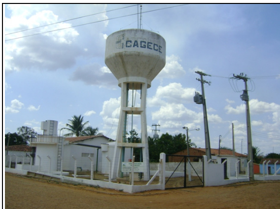
Foto 4 – Vista da ETA.
