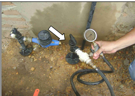
Foto 57 – Medição de pressão na Av. Perimetral, nº 338 - Bairro Vila Liberdade, antes do hidrômetro.
