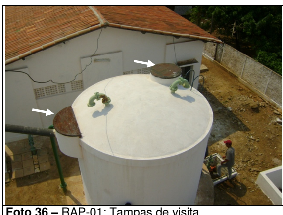
Foto 36 – RAP-01: Tampas de visita.
