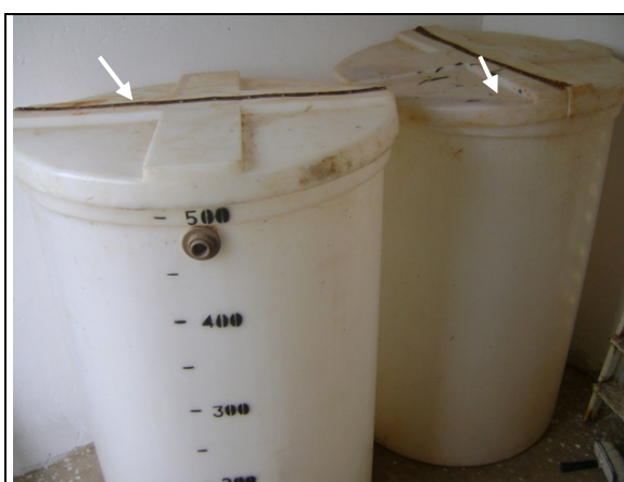
Foto 47 – RAP-05: Tanques de mistura de produto químicos.
