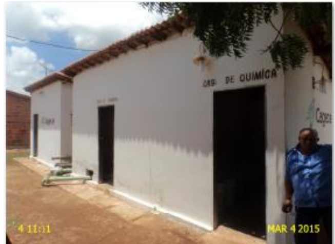
Foto 4 - EECs: ausência de identificação.
