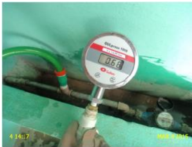
Foto 1 - RDA: medição instantânea de pressão na Rua Boa Esperança, 110.
