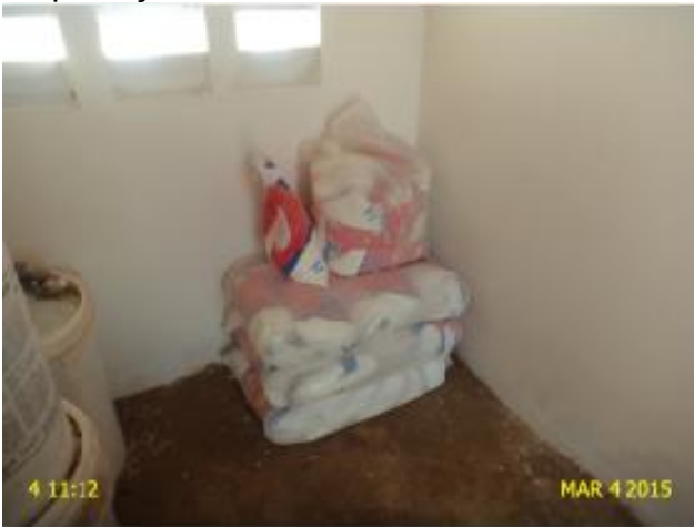
Foto 5 - Casa de química: produtos armazenados inadequadamente.
