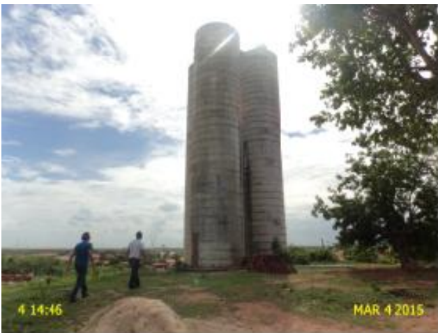
Foto 2 - Reservatórios: sem delimitação.
