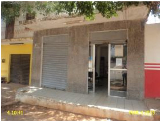
Foto 12 - Escritório/loja de atendimento: ausência de identificação.
