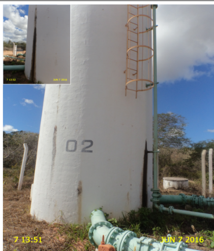
Foto 28 – TAU-02: apresenta 2 (dois) vazamentos na parede.
