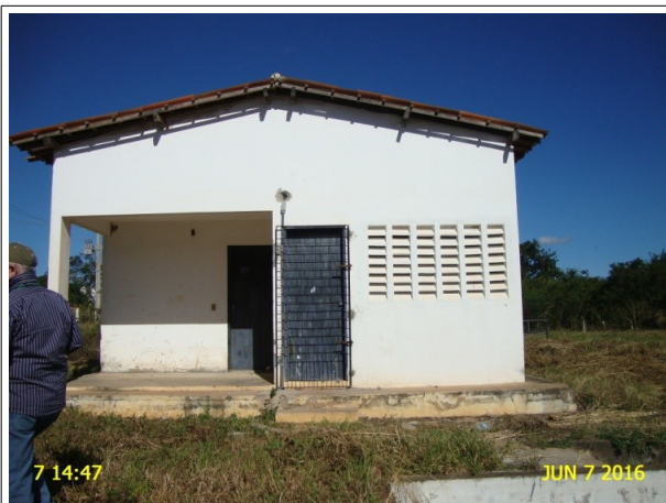
Foto 20 – EEAT-03 (Tianguá): ausência de identificação.
