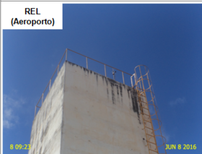
Foto 09 – REL (Aeroporto): ausência de para-raios e sinalizador noturno.
