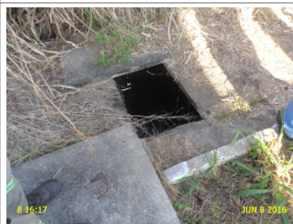
Foto 23 - ETE São Gonçalo: caixa de passagem aberta.
