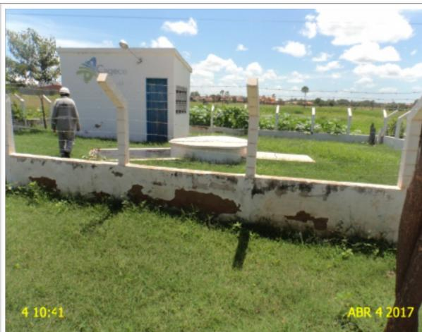
**Foto 26** – EEE-01: parede com pintura e reboco deteriorados.
