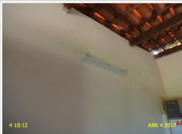
**Foto 29** – ETE: ausência de lâmpada na área de armazenamento de produtos químicos na casa de apoio ao operador.
