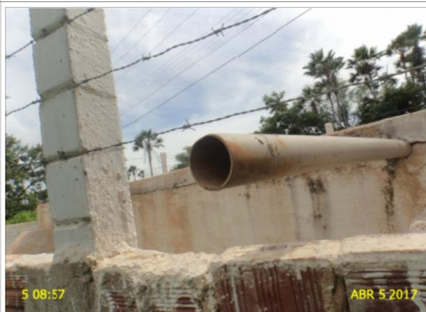
**Foto 28** – RSE-01: tubulação de ventilação sem tela de proteção.
