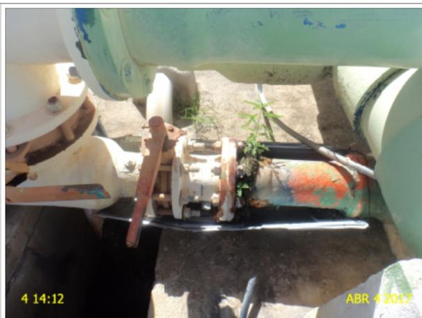
**Foto 14** – Filtro F-04: vazamento na flange.
