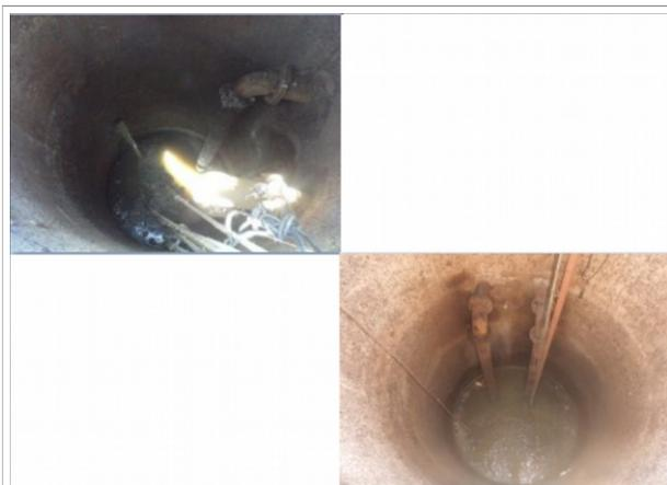
**Foto 1** – EEE-01 e EEE-02: não existe bomba reserva instalada.
