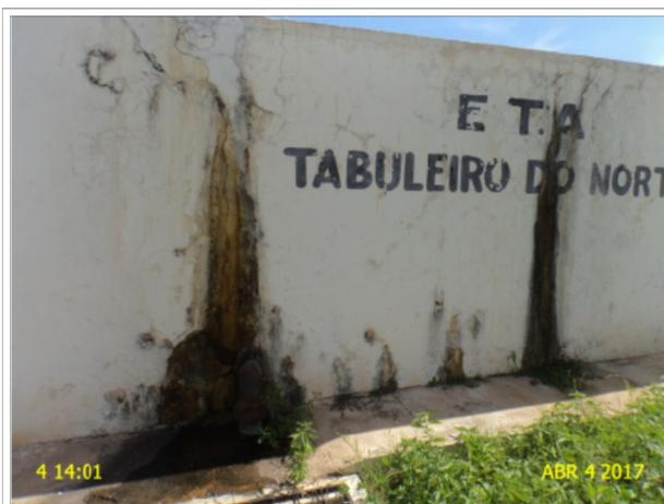
**Foto 5** – Decantador: sinais de vazamento na estrutura.
