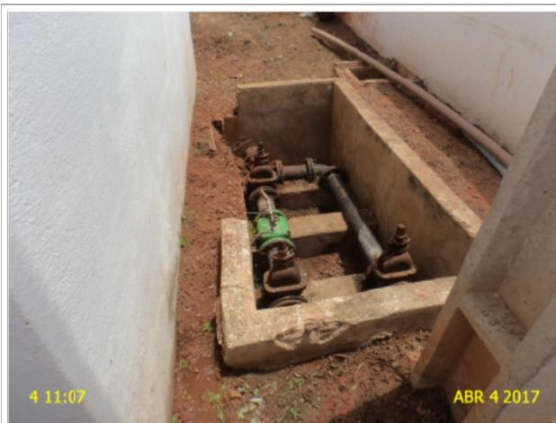
**Foto 19** – AAT: caixa de inspeção deteriorada na área da EERD-02 e do RAP-02.
