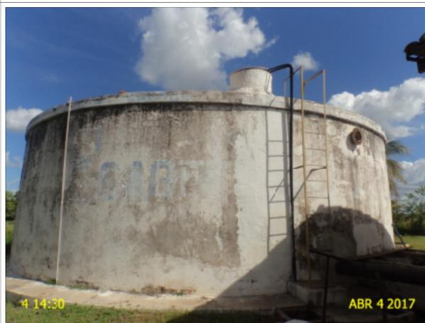
**Foto 10** – RAP-01: pintura deteriorada e ausência de identificação.
