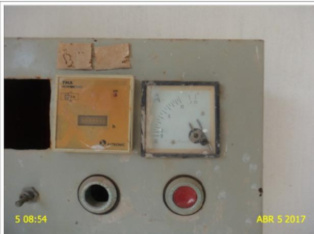
**Foto 32** – EERD-01: amperímetro quebrado, sem ponteiro.
