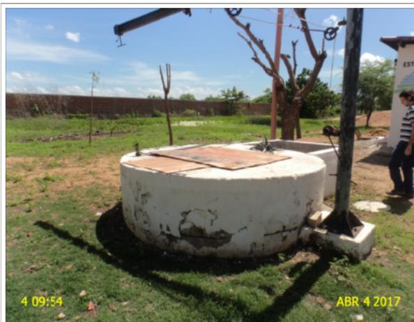
**Foto 25** – EEE-02: poço de sucção com armadura exposta e reboco deteriorado.
