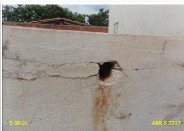
**Foto 4** – RSE-02: ausência de tubulação de ventilação.
