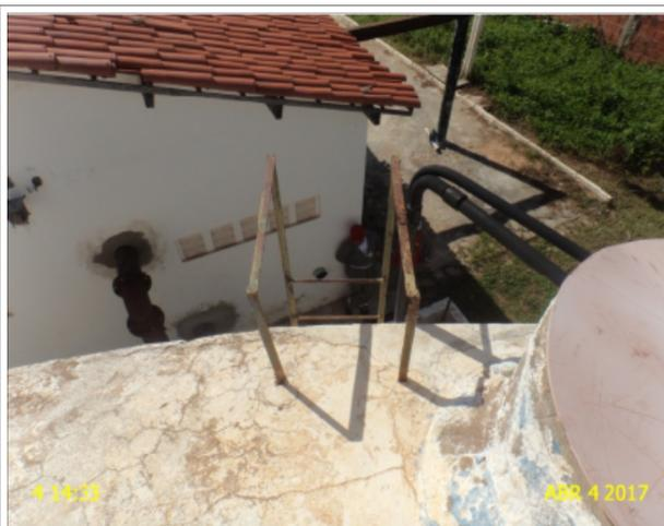
**Foto 20** – RAP-01: escada em processo de corrosão.
