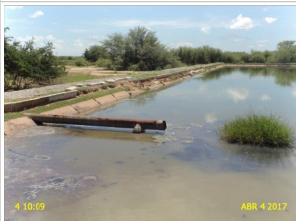
**Foto 17** – ETE: tubulação em processo de corrosão.
