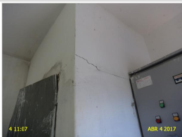
**Foto 7** – EERD-02 (Mutirão): rachadura na parede da casa de abrigo.
