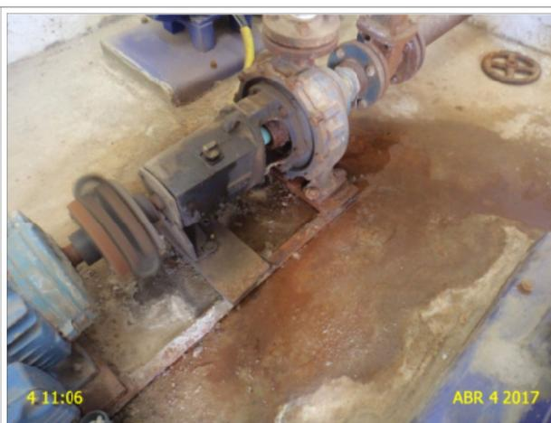
**Foto 6** – EERD-02 (Mutirão): vazamento na bomba.
