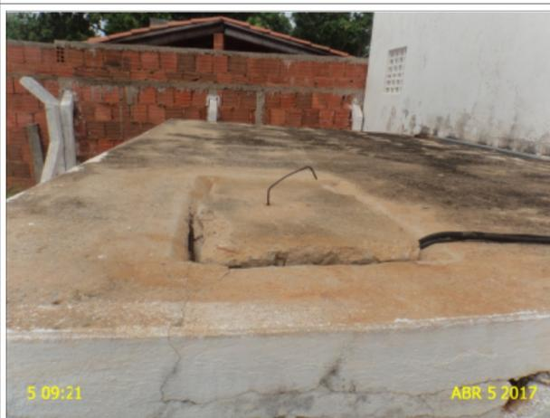
**Foto 24** – RSE-02: tampa de inspeção inadequada.
