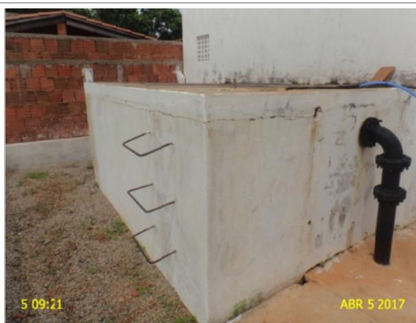
**Foto 11** – RSE-02: pintura deteriorada e ausência de identificação.
