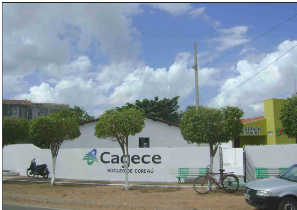
Foto 11 – Vista externa do escritório da CAGECE.
