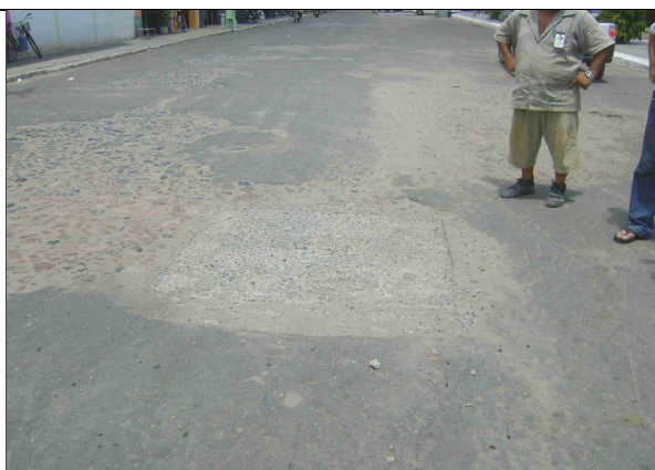
Foto 9 – Registro de manobra localizado na Rua Antônio Cristino.
