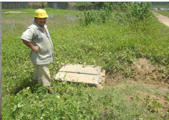
Foto 7 – Registro de descarga localizado na Rua Ângelo Carneiro.
