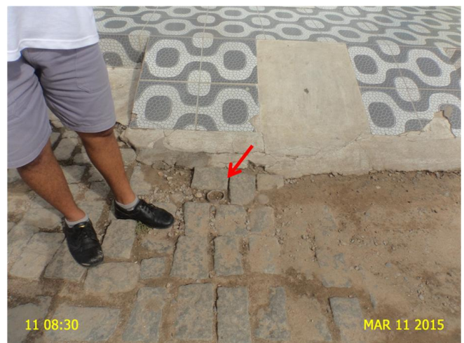
Foto 18 – RDA: registro de descarga sem caixa localizado na R. Pe. Lino Aderaldo.
