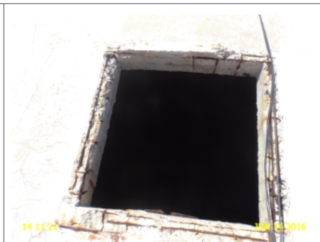
Foto 04 - REL-01: ausência de tampa.
