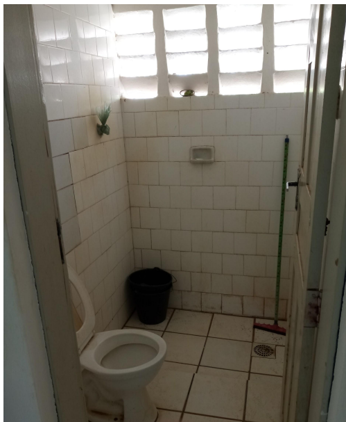
Foto 13 - ETA: Manutenção do banheiro
