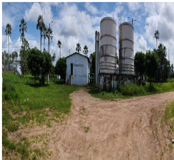
Foto 24 - ETA: Área a ser pavimentada.
