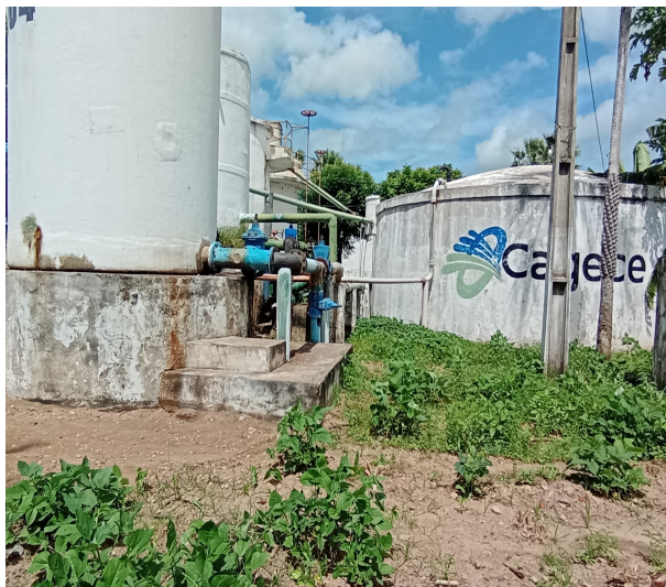
Foto 25 - ETA: Área a ser pavimentada.
