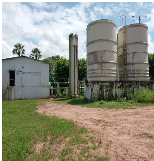
Foto 26 - ETA: Área a ser pavimentada
