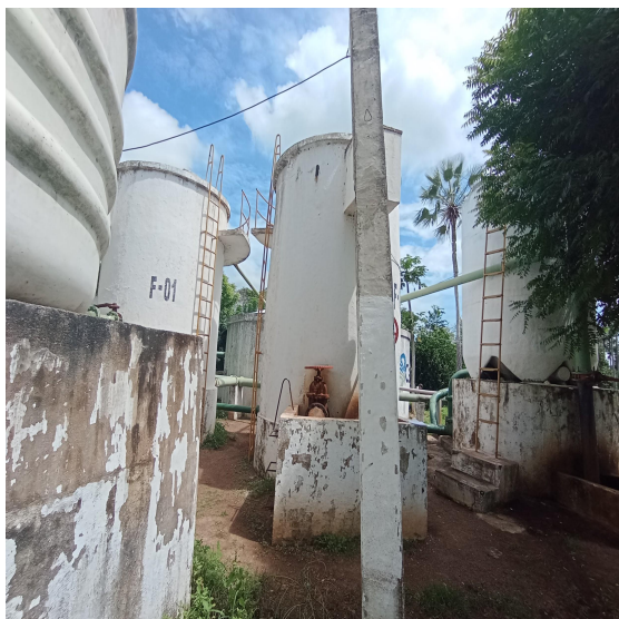
Foto 23 - ETA: Área a ser pavimentada.
