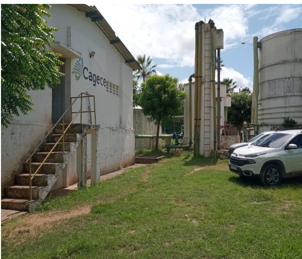
Foto 27 - ETA: Área a ser pavimentada.
