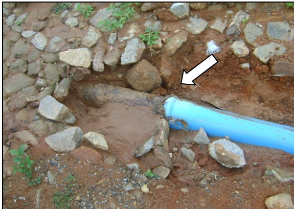
Foto 60 – Junção da adutora de água bruta antiga com a nova.
