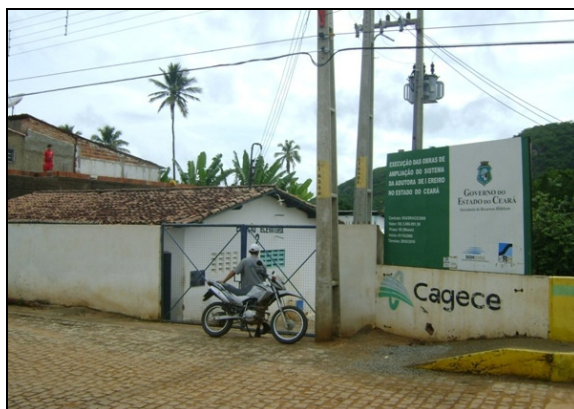
Foto 2 – Entrada da ETA.
