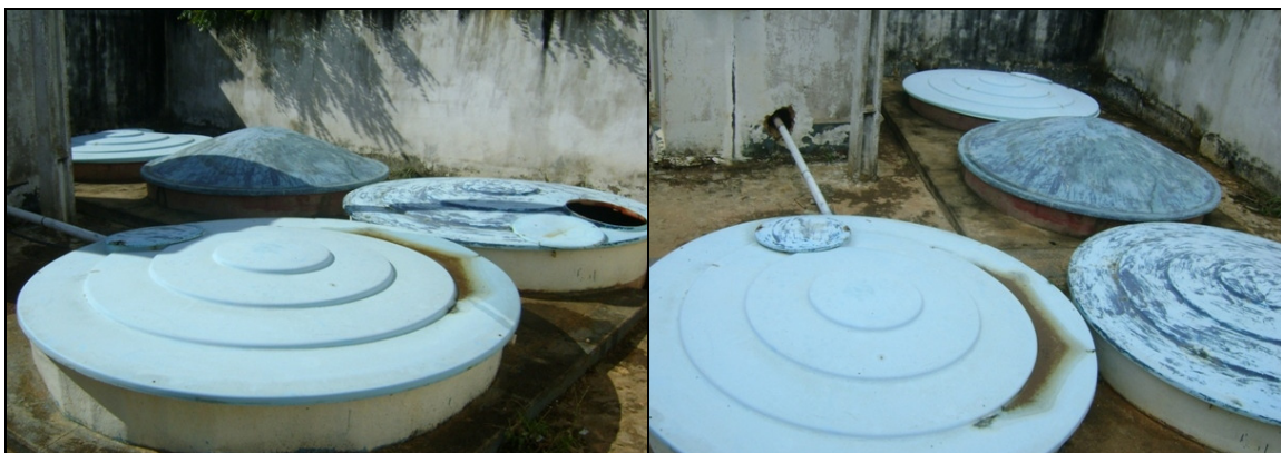
Fotos 56 e 57 – Vistas dos REN's-01, 02, 03 e 04.
