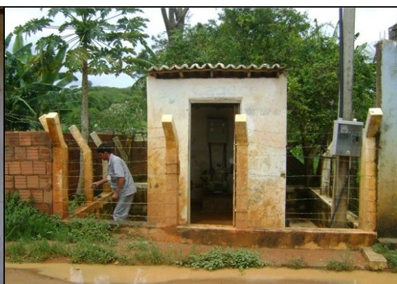
Foto 36 – Prédio de abrigo da EERD-02.
