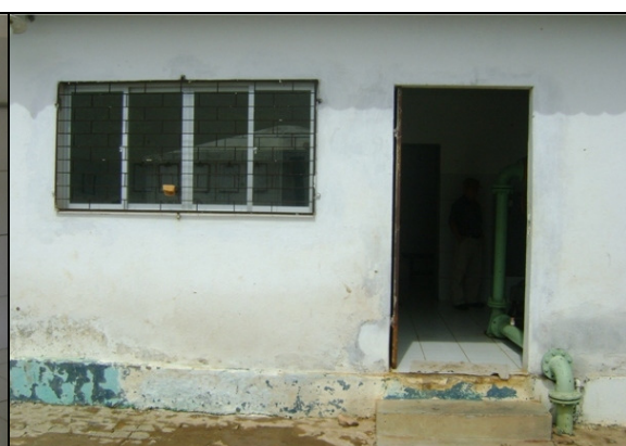
Foto 29 – Prédio de abrigo das elevatórias EELF-01 e EEAT-01.
