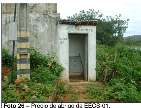
Foto 26 – Prédio de abrigo da EECS-01.
