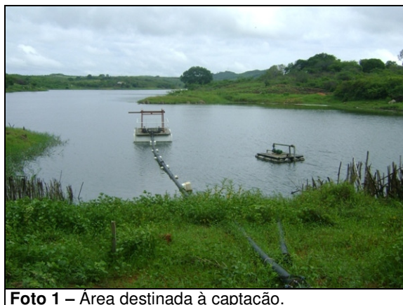
Foto 1 – Área destinada à captação.
