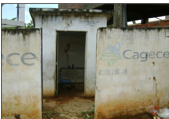
Foto 32 – Prédio de abrigo da EERD-01.
