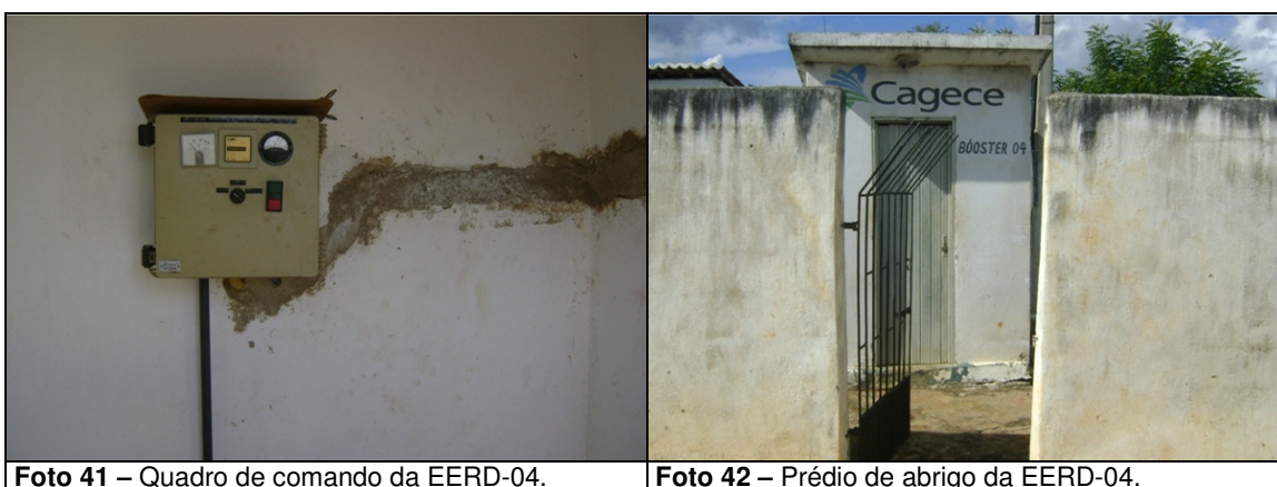
Foto 41 – Quadro de comando da EERD-04.
