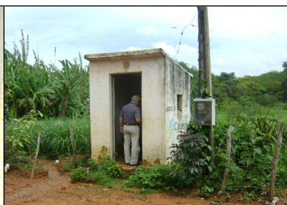
Foto 45 – Prédio de abrigo da EERD-05.
