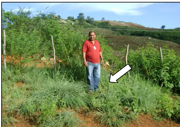
Foto 67 – Registro de descarga soterrado, no Sítio Mamoeiro, CE-138.
