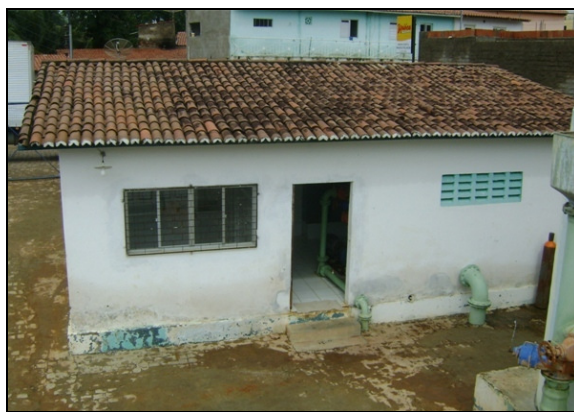
Foto 6 – Casa de química.
