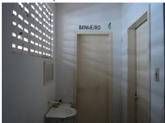
Foto 55 – Loja de Atendimento: instalações sanitárias.
