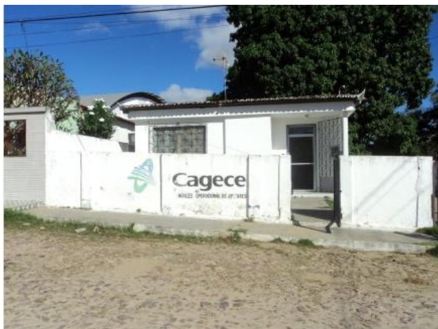
Foto 51 – Loja de Atendimento: vista externa.
