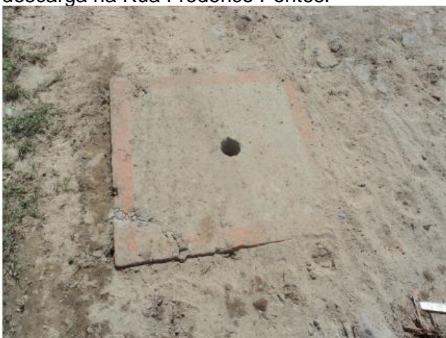
Foto 44 – Rede de distribuição: registro de descarga na Rua H.
