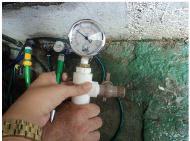
Foto 48 – Medição instantânea de pressão na Rua Luiz Carneiro de Azevedo, 199.
