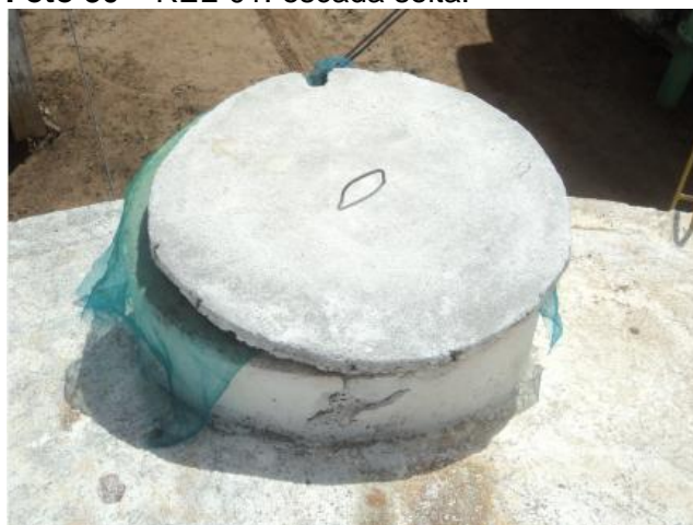
Foto 32 – RAP-01: tampa de inspeção.
