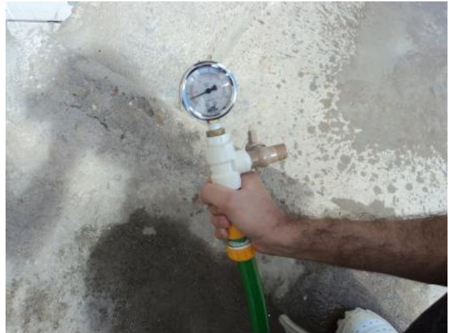
Foto 46 – Medição instantânea de pressão na Rua José Nojosa Freitas, 21.
