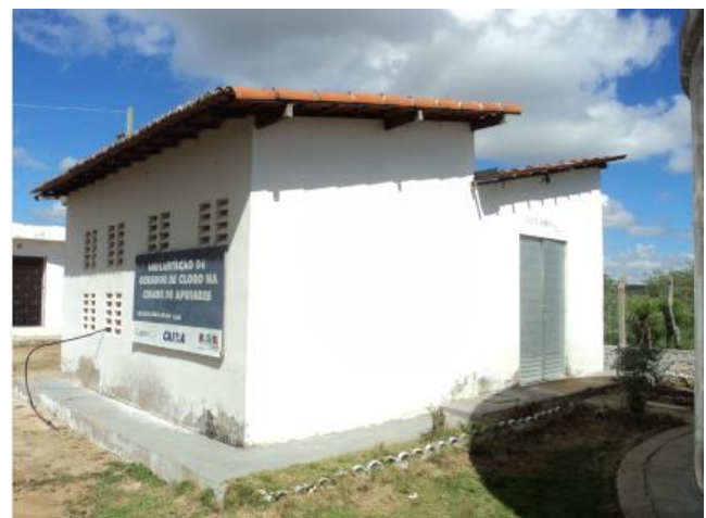
Foto 9 – Casa de química: vista externa.
