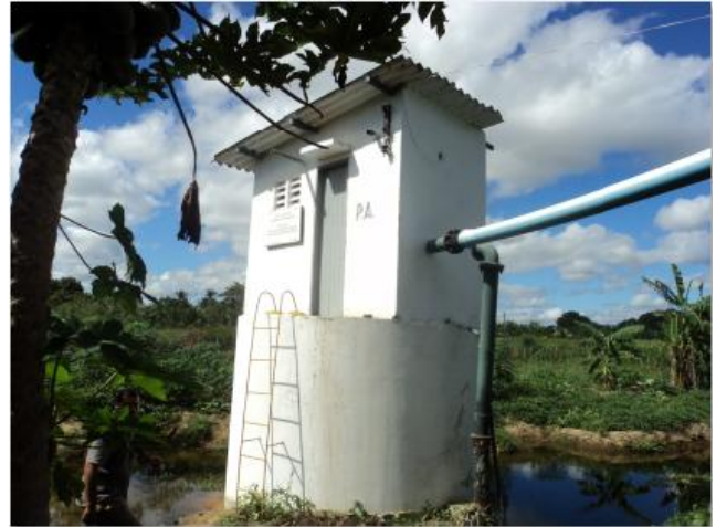
Foto 2 – PA: vista geral.
