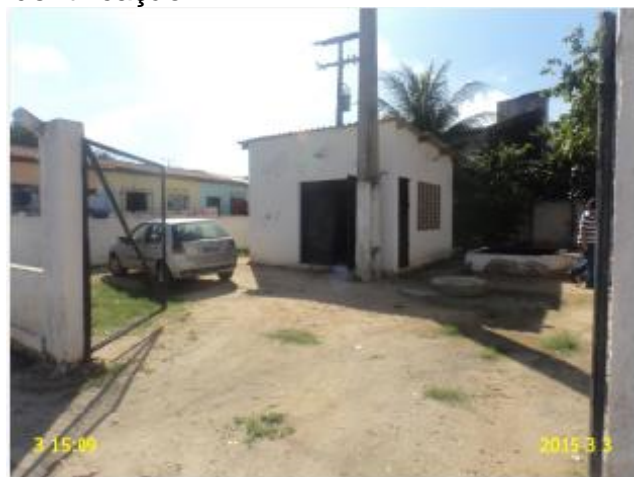
Foto 8 – EEE-Rondon III: ausência de identificação.
