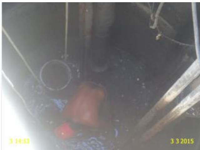
Foto 12 – ETE-Rondon I: operador sem EPIs.
