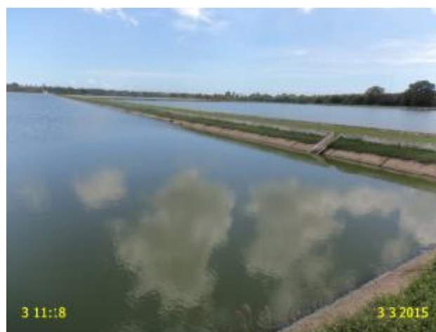
Foto 2 – ETE Junco: ausência de iluminação para trabalhos noturnos.
