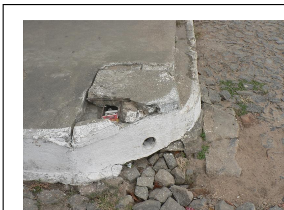
Foto 01 – Saída da descarga do REL.
