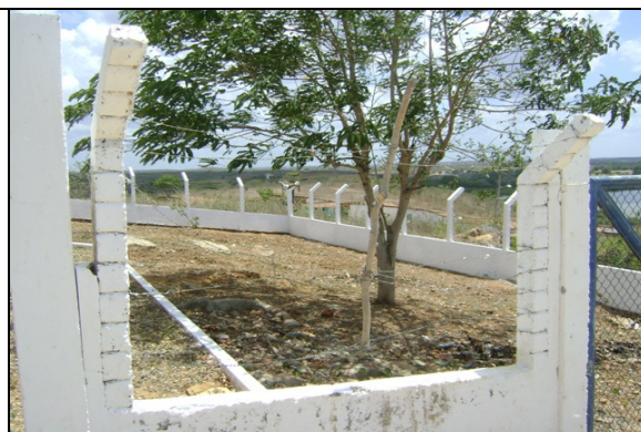
Foto 30 – REL-02 – cerca de proteção.
