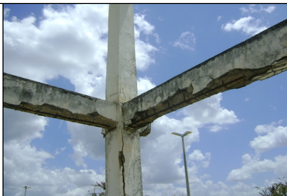
Foto 38 – REL-04 – vigas de amarração.
