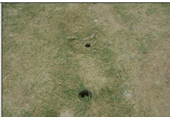
Foto 46 – Registro de descarga na rede de distribuição.
