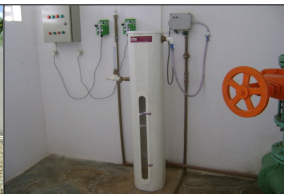
Foto 15 – Sistema de fluoretação.
