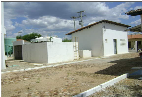
Foto 21 – RAP-01 – sem identificação.
