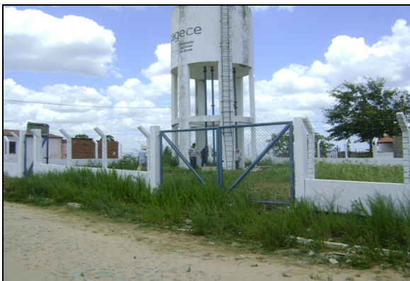
Foto 31 – REL-03 – área sem limpeza.
