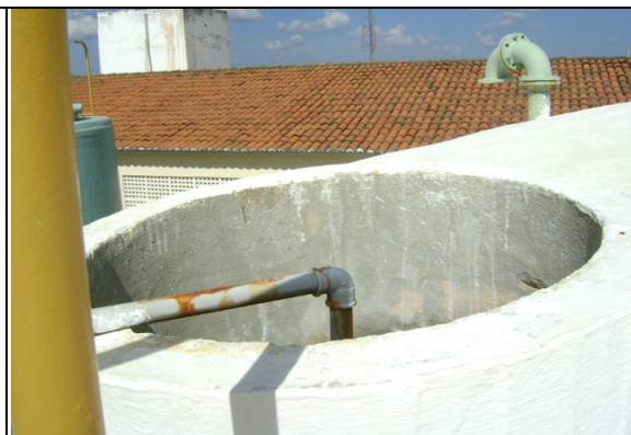
Foto 24 – RAP-02 – chaminé de inspeção.
