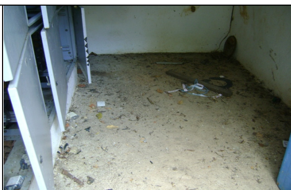
Foto 4 – Área interna da casa de proteção do quadro de comando, na captação.
