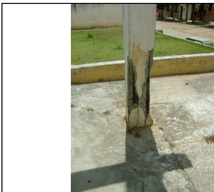
Foto 37 – REL-04 – pé da coluna de sustentação.
