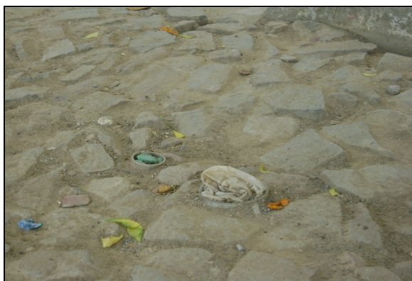
Foto 45 – Registro de descarga na rede de distribuição.
