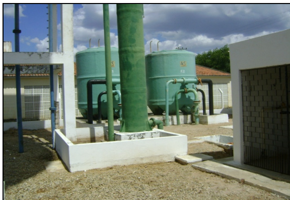
Foto 6 – Vista parcial da ETA do SAA de Paramoti.
