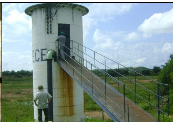
Foto 31 – Prédio de abrigo da EEPA-01.
