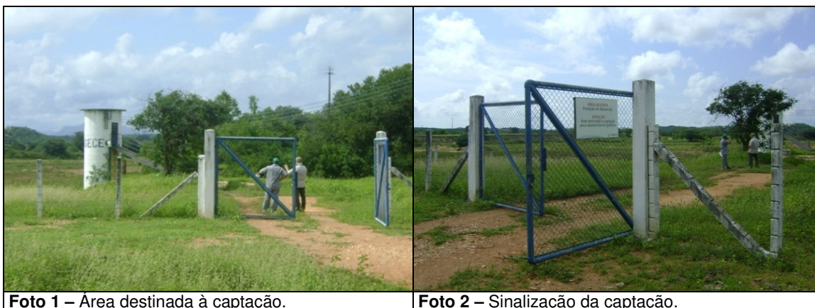
Foto 1 – Área destinada à captação.
