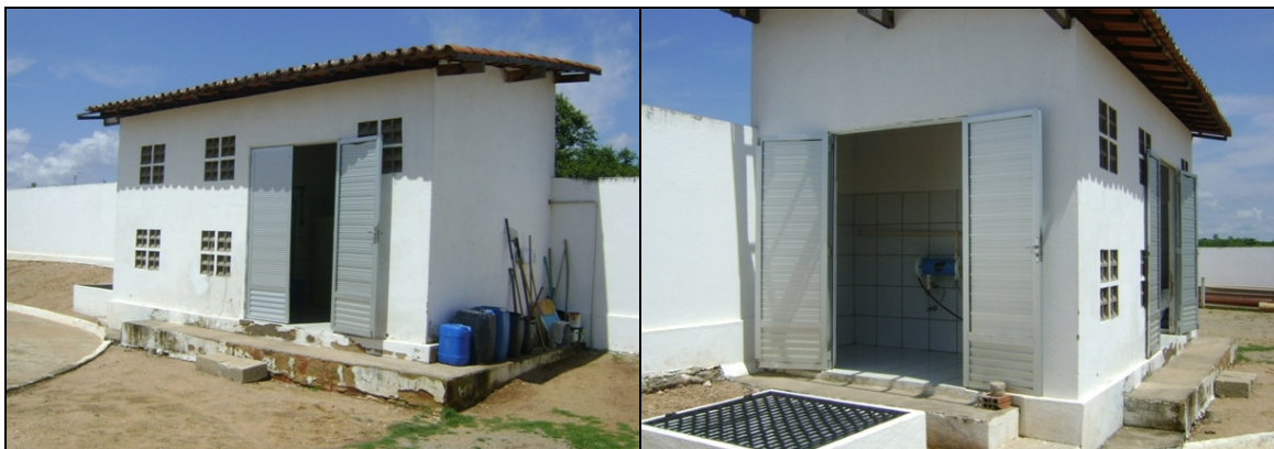
Fotos 14 e 15 – Vistas da fábrica de cloro.
