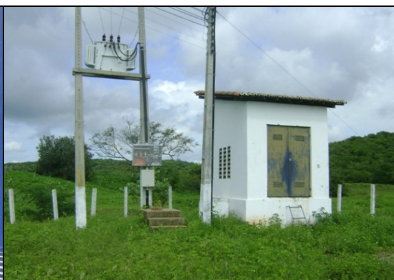
Foto 33 – Prédio de abrigo do quadro de comando da EEPA-01.
