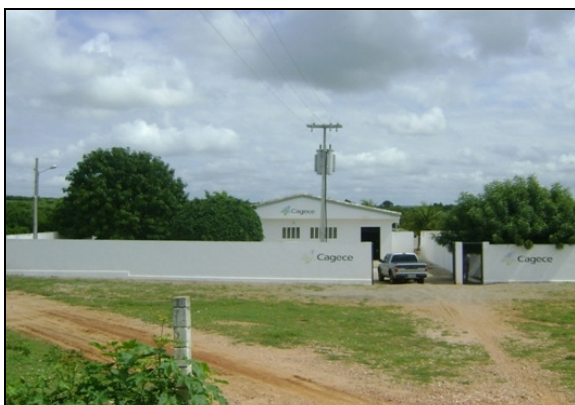
Foto 3 – Entrada da ETA.
