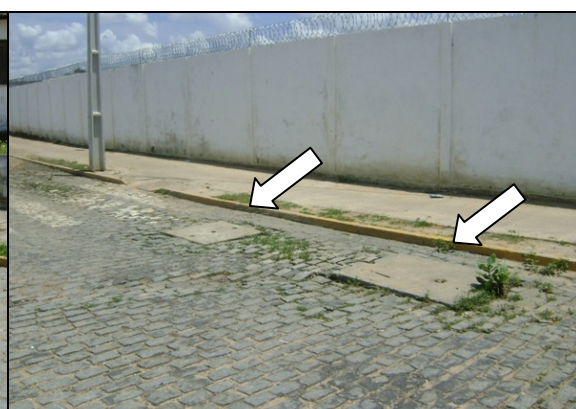
Foto 64 – Registros de manobra e descarga na Av. Vereador Sobrinho, Centro.
