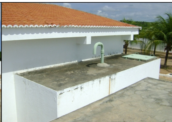
Foto 44 – Ventilação e visita do Tanque de Reunião.
