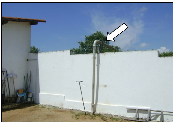
Foto 55 – Ponto de abastecimento de carro-pipa.
