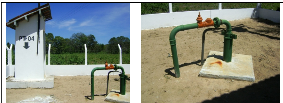
Fotos 2 e 3 – Vistas do PT-04.
