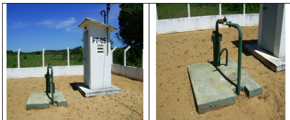
Fotos 5 e 6 – Vistas do PT-05.
