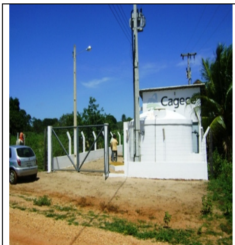
Foto 1 – Vista externa da área do PT-04.
