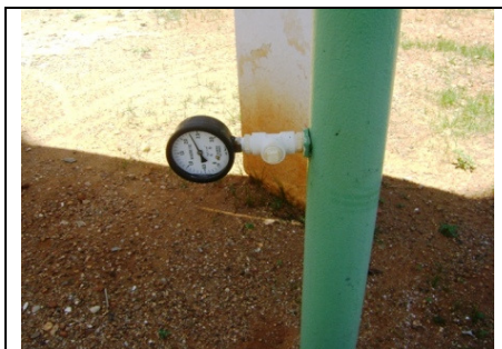
Foto 30 – Medição de nível do REL-01
