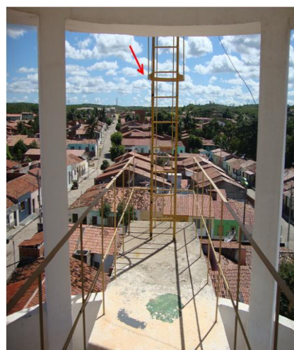
Foto 52 – Vista do REL-01 com guarda-corpo na escada de acesso.
