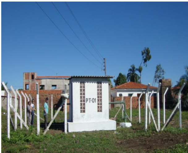
Foto 1 – Vista externa do PT-01.
