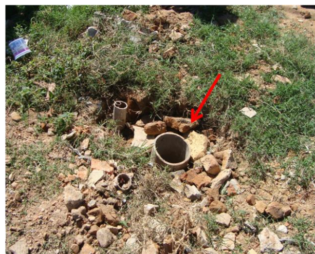
Foto 69 – Registro de descarga na Rua Sebastião Nunes Pereira, nº 64.
