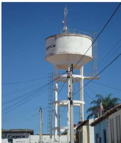
Foto 49 – Vista do REL-01.
