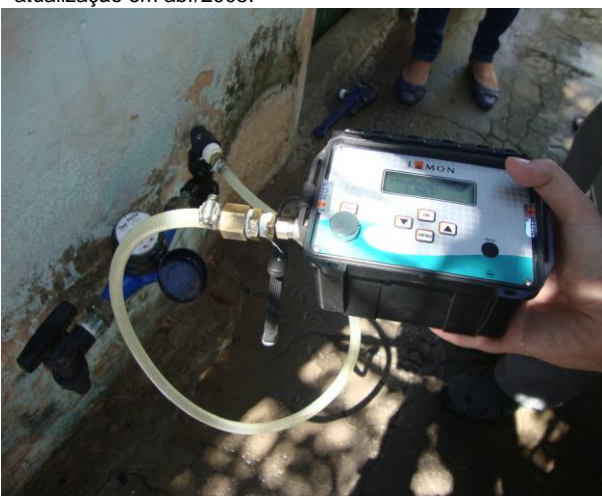
Foto 62 – Medição de pressão instantânea na Av. Gilvan Moraes, nº 595 – Triângulo.
