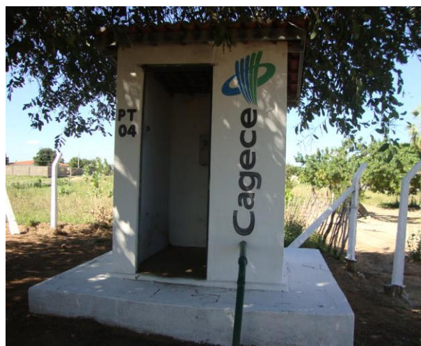
Foto 12 – Casa de abrigo do quadro de comando do poço PT-04.
