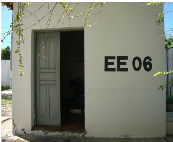
Foto 36 – Vista externa da elevatória EE-06.
