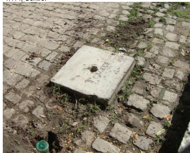
Foto 67 – Registro de descarga na Rua Santos Dumont, nº 49.
