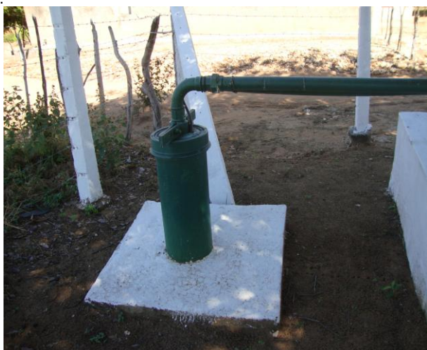
Foto 11 – Vista do poço PT-04.
