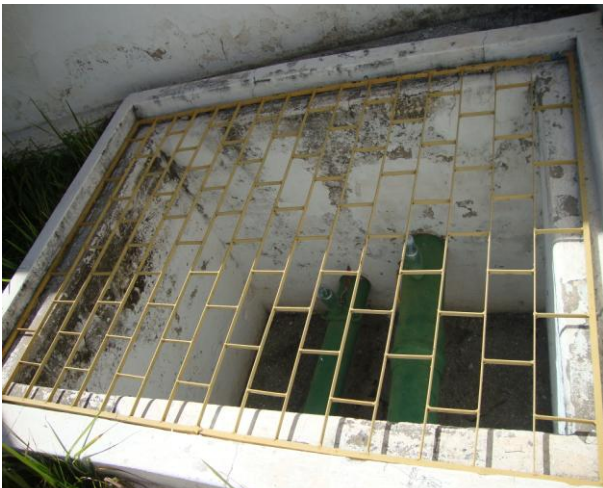
Foto 32 – Estações pitométrica na adutora de água bruta no interior da ETA.
