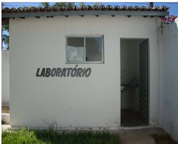
Foto 25 – Vista externa do laboratório.
