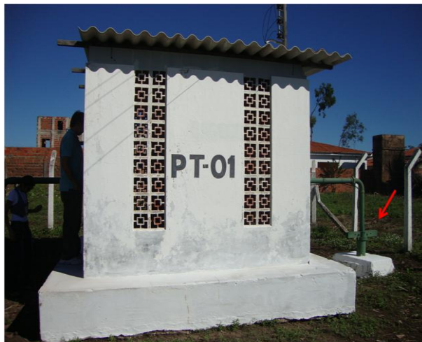
Foto 2 – Vista do PT-01 e da casa de abrigo do quadro de comando.
