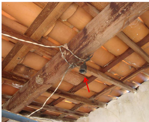
Foto 8 – PT-02 sem luminária.
