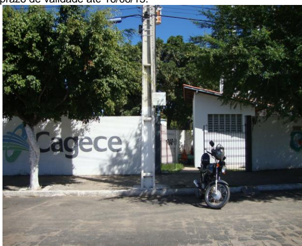
Foto 17 – Vista externa da ETA.
