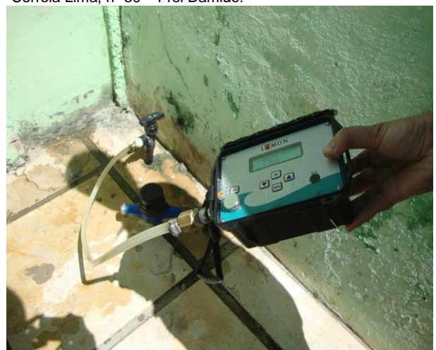
Foto 63 – Medição de pressão instantânea na Av. Lacordaire Lins, nº 153 – Centro.
