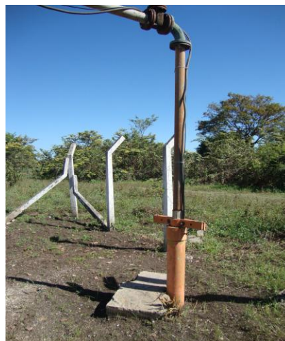
Foto 6 – Vista do poço PT-02.
