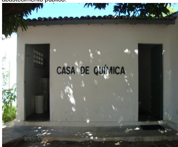
Foto 18 – Vista externa da casa de química.
