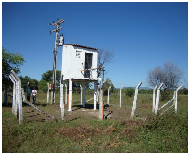
Foto 5 – Vista externa do poço PT-02.
