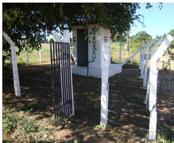
Foto 10 – Vista externa do poço PT-04.
