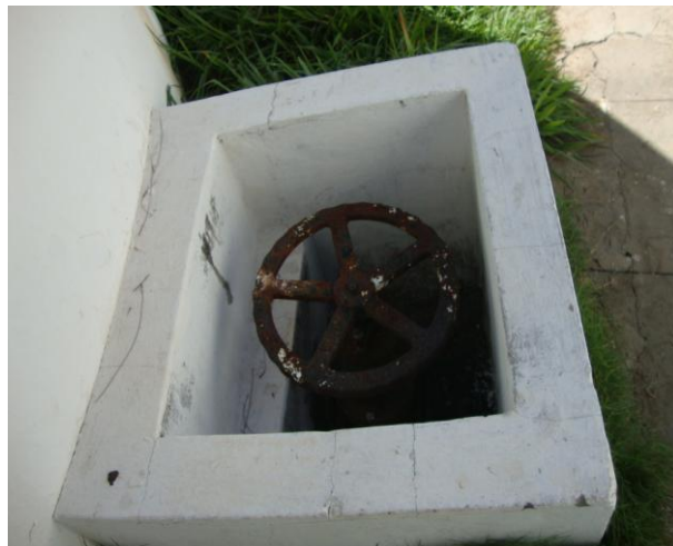
Foto 48 – RAP-01: Registro de descarga.
