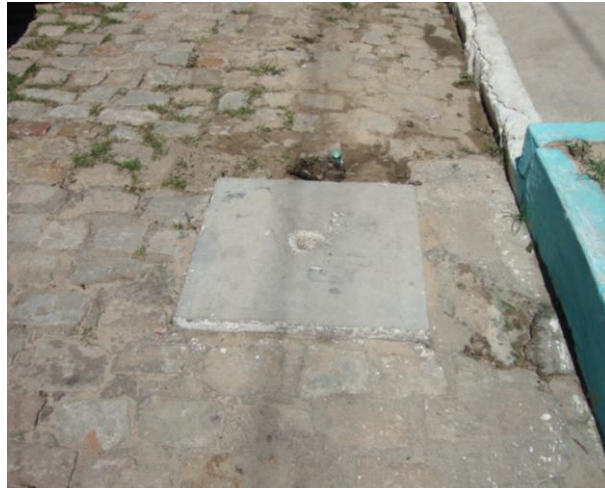
Foto 71 – Registro de descarga na Rua José Miguel de Figueiredo, nº 9.
