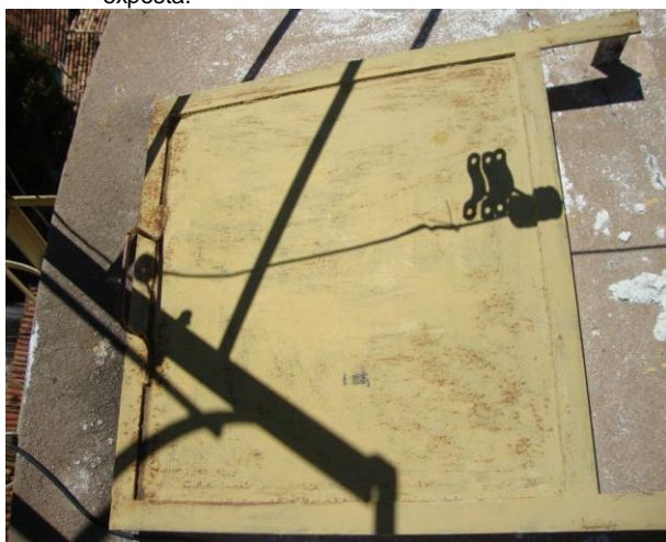
Foto 55 – REL-01: tampa de inspeção em adequada condição de vedação.
