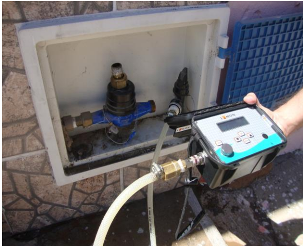
Foto 64 – Medição de pressão instantânea na Rua João Fechine, nº 42 – Centro.
