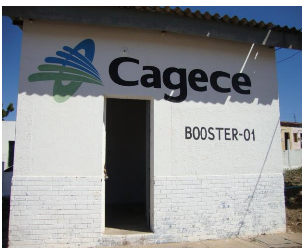
Foto 40 – Vista externa do Booster 01.
