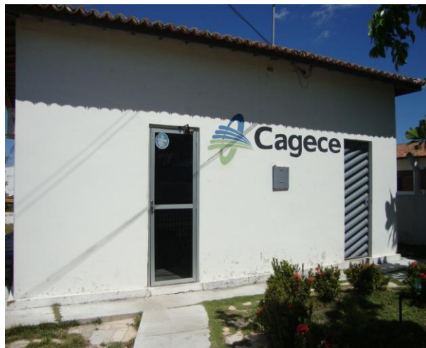
Foto 73 – Vista externa do escritório/loja de atendimento ao usuário.
