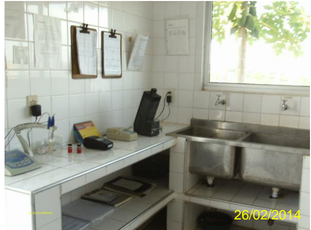
Foto 32 - ETA laboratório: vista geral.
