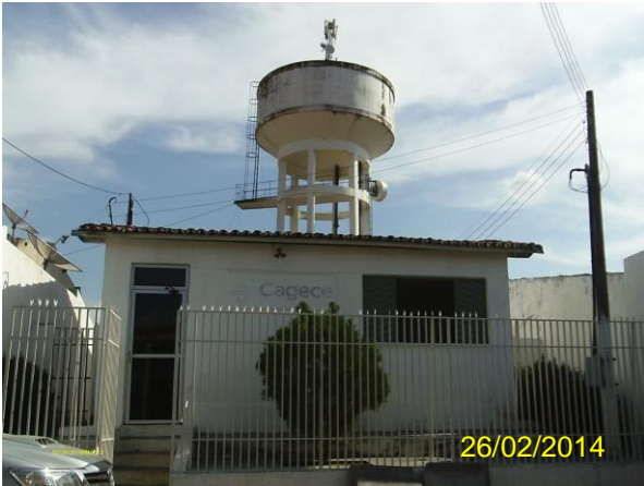
Foto 88 - Escritório: identificação apagada.
