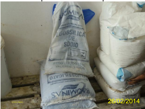
Foto 29 - ETA casa de química: flúor armazenado em estrados e dentro do prazo de validade.
