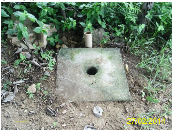
Foto 84 - Registro de descarga na rede de distribuição: Vila Freire.
