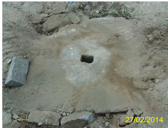
Foto 83 - Registro de descarga na rede de distribuição: Praça da Vitória.
