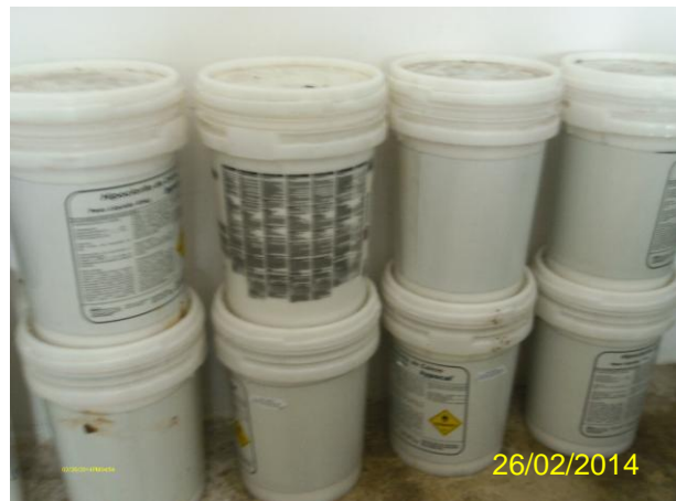
Foto 30 - ETA casa de química: hypocal armazenado sem estrados e dentro do prazo de validade.
