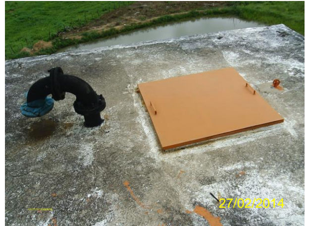
Foto 60 - REL-02: tampa de inspeção e tubulação de ventilação.
