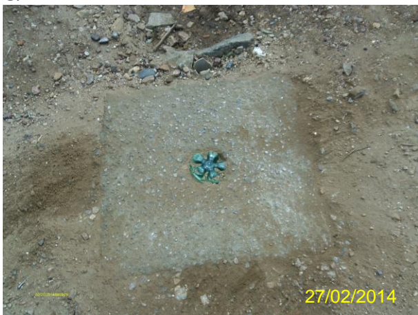
Foto 78 - Registro de descarga na rede de distribuição: Rua Vereador Vito Leite.
