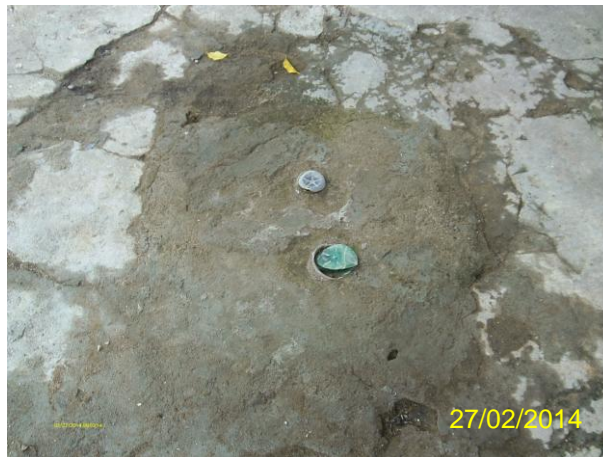
Foto 77 - Registro de descarga na rede de distribuição: Rua Sebastião Alves Pereira.
