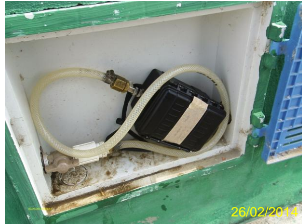
Foto 71 - Equipamento de medição contínua de pressão datalogger instalado na Rua SDO 167, Conj. Habitat José Fernandes Campos.
