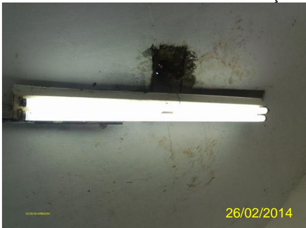
Foto 5 - PA-01: iluminação interna.
