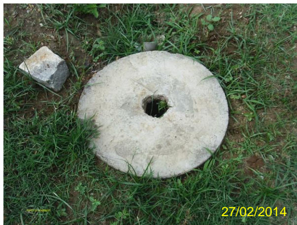
Foto 79 - Registro de descarga na rede de distribuição: Rua Guedes Martins.
