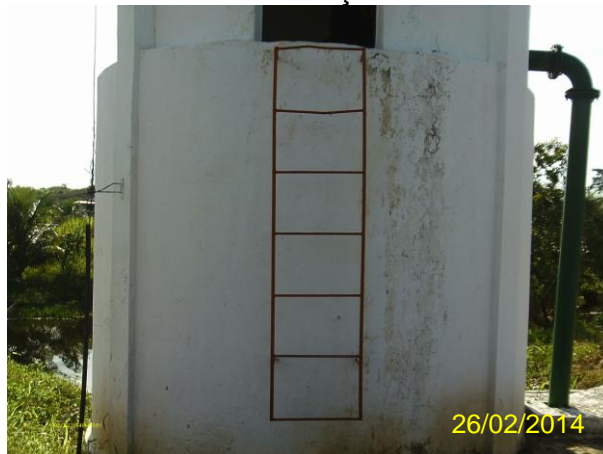
Foto 6 - PA-01: escada de acesso.
