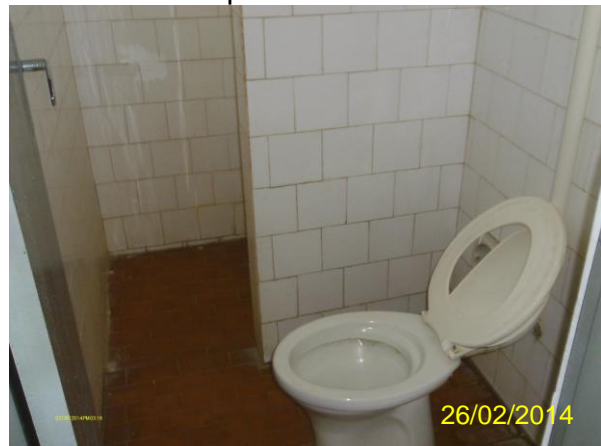
Foto 91 - Escritório: instalações sanitárias.
