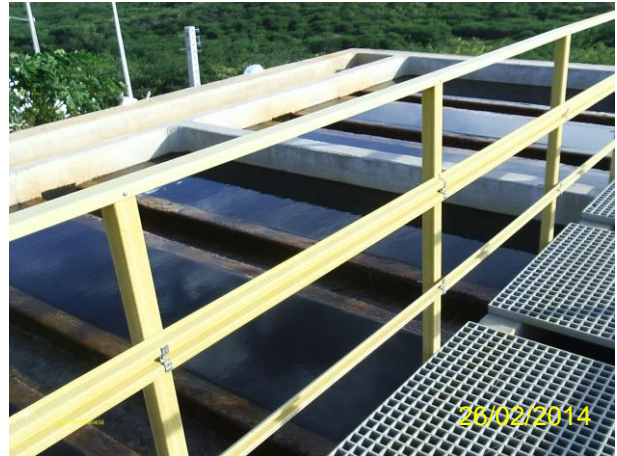
Foto 14 - ETA decantação: passarela com guarda-corpo.
