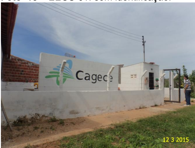
Foto 15 – EEAT-07: sem identificação.
