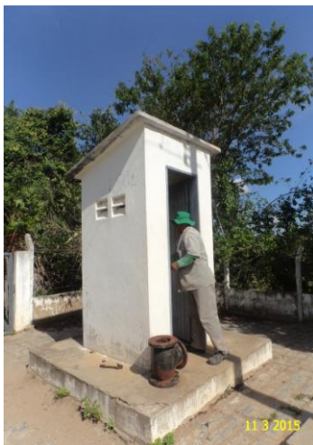
Foto 13 – EECS-01: sem identificação.
