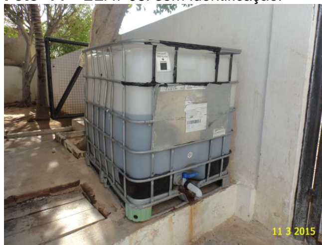
Foto 16 – ETA: produto químico de forma inadequada.
