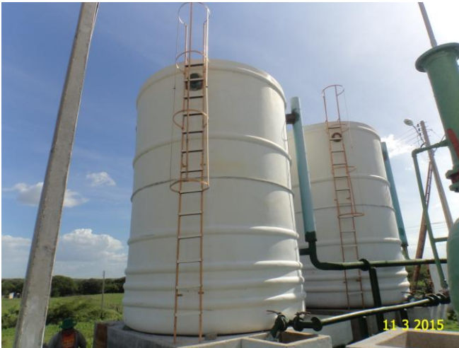
Foto 17 - ETA: decantadores sem identificação.
