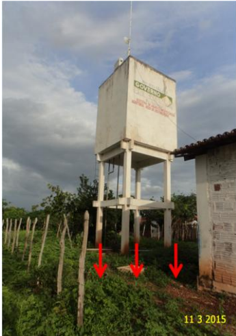
Foto 29 – REL-04: área sem portão de acesso e identificação.
