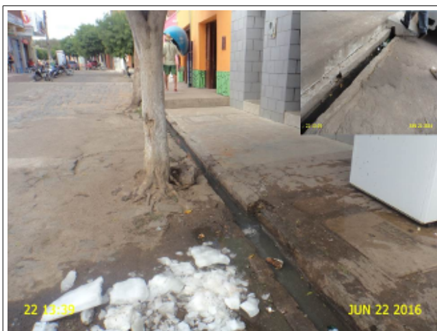
Foto 09 - Lançamento de esgoto a céu aberto na Rua José Cândido de Araújo.
