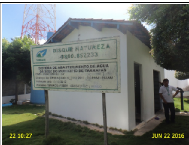
Foto 10 - Placa com a data de validade da licença de operação da ETA Tarrafas vencida.
