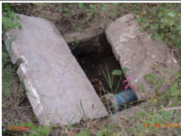
Foto 75 – RDA (Sede): tampa da caixa do registro de descarga aberta na Rua Juvêncio Alves de Oliveira.
