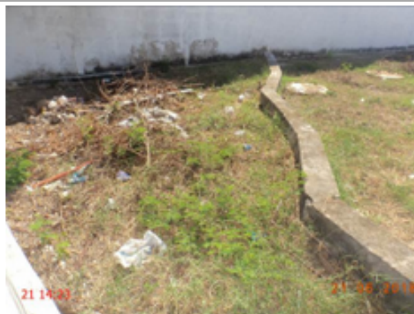
Foto 38 – ETE COHAB: acúmulo de lixo.
