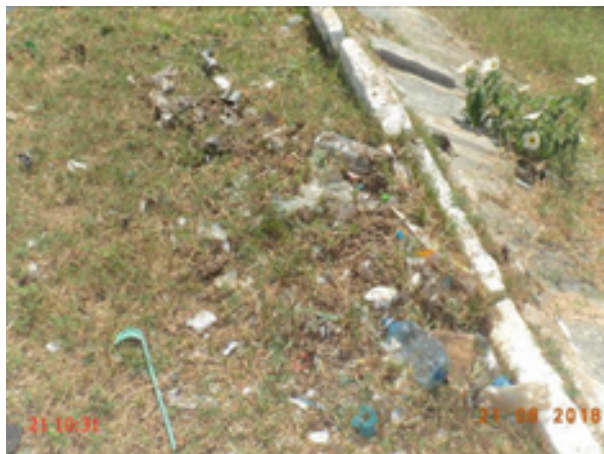
Foto 35 – ETE Campo Novo: acúmulo de lixo.
