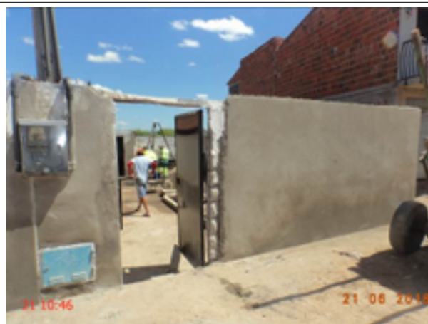
Foto 48 – EEE-06 (Sede): sem identificação.
