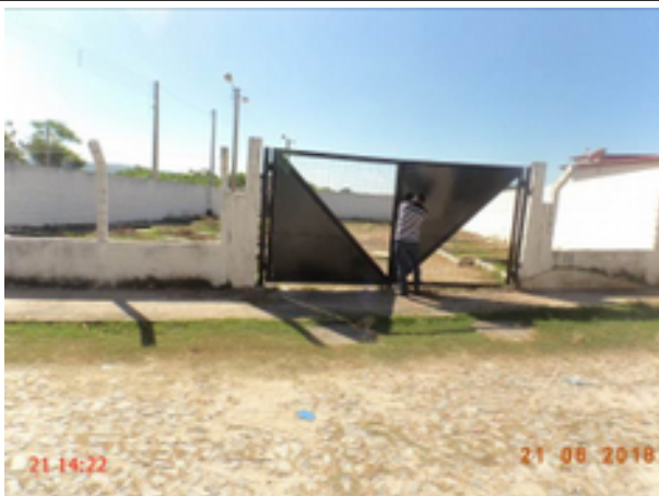
Foto 77 – ETE COHAB (SES): sem identificação.
