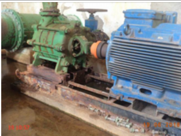
Foto 53 – EEAB-01 (Sede): vazamento na gaxeta da bomba.
