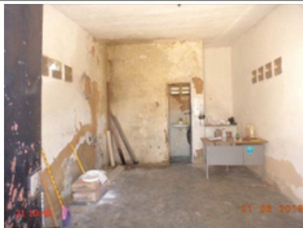
Foto 26 – ETE Campo Novo: pintura e reboco deteriorados na casa de abrigo do operador e ausência de lâmpada..
