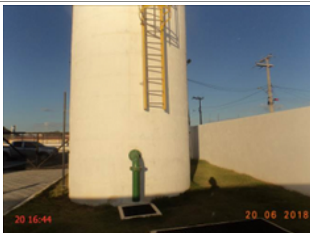
Foto 47 – REL-MCMV Raquel de Queiroz (Sede): sem escada de apoio para acessar a escada principal.
