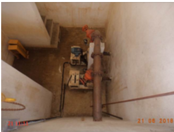
Foto 9 – – EEE-08 (Sede): apenas uma das bombas instalada.
