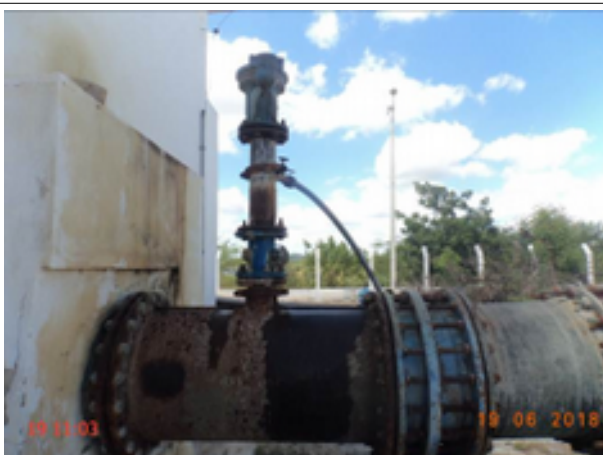
Foto 53 – EEAB-01 (Sede): vazamento na gaxeta da bomba.
