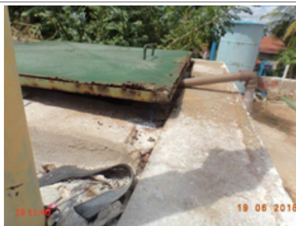
Foto 92 – RSE-02 (Tapuiará): tampa de inspeção sem vedação (1).
