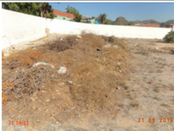
Foto 37 – ETE Chico Braz: acúmulo de lixo.
