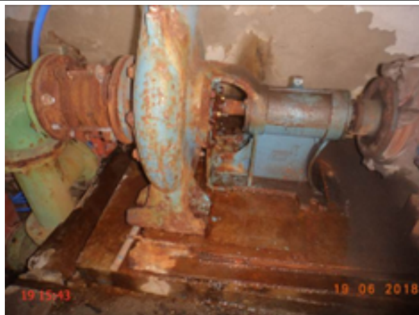
Foto 54 - EEAT-03 (Sede): vazamento na gaxeta da bomba.
