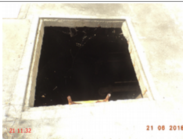
Foto 92 – RSE-02 (Tapuiará): tampa de inspeção sem vedação (1).
