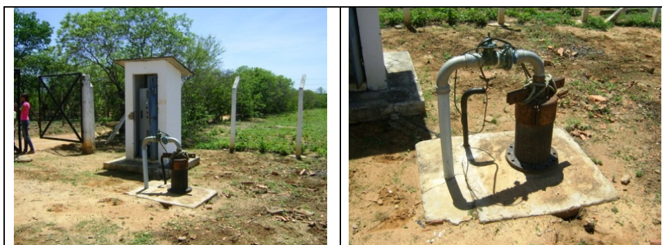
Fotos 6 e 7 – Vistas do PT-04.
