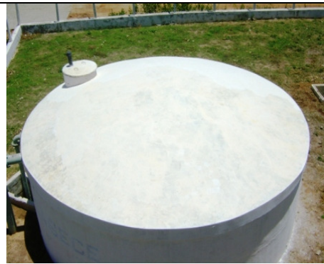
Foto 34 – Vista da laje superior do RAP-04.
