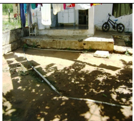
Foto 2 – Vista interna da área do PT-03.
