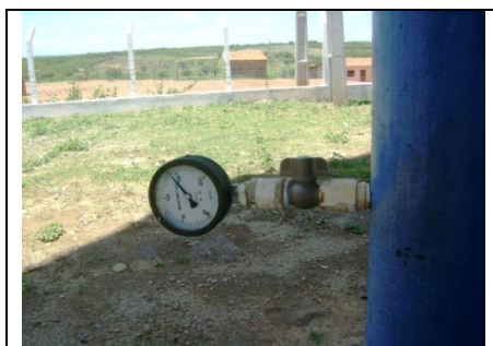
Foto 39 – Medição de nível do REL-01
