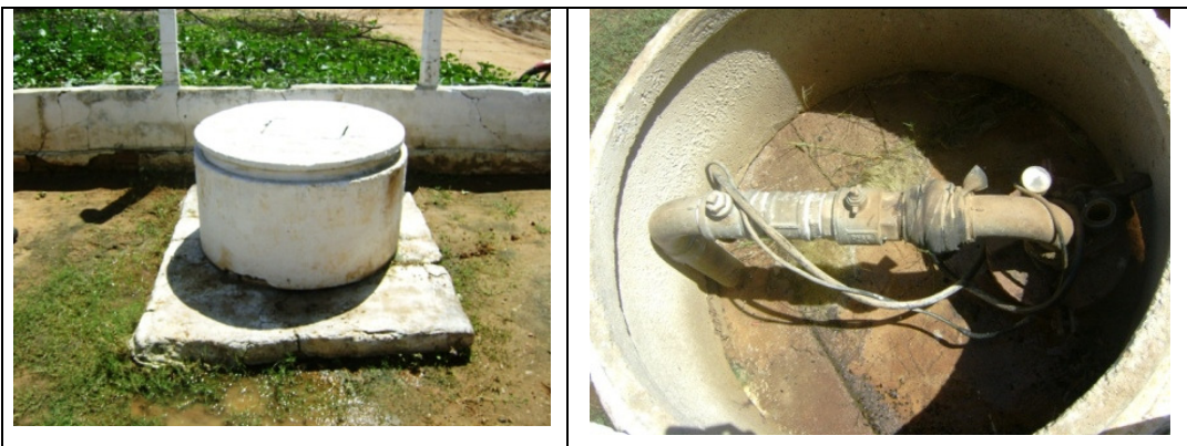
Fotos 3 e 4 – Vistas do PT-03.
