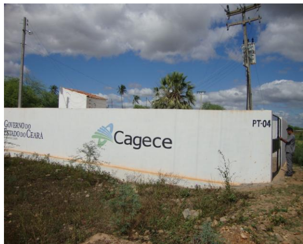
Foto 13 – Vista externa do PT-04.
