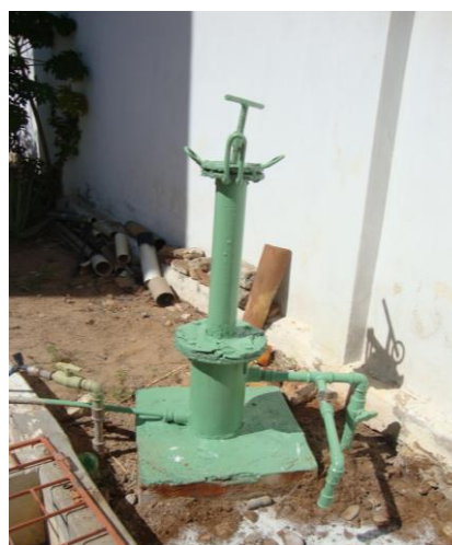
Foto 29 – Clorador de pastilha: linha de alimentação do REL-02.
