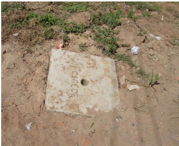
Foto 74 – Registro de descarga na Rua Bela Vista 02.
