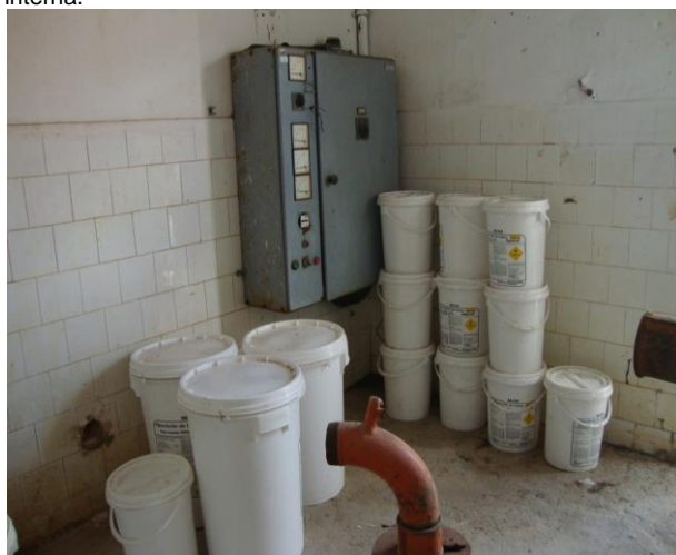
Foto 38 – Vista interna do almoxarifado de produtos químicos.
