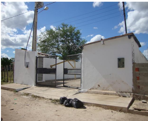
Foto 82 – Vista da externa da EEE-01.
