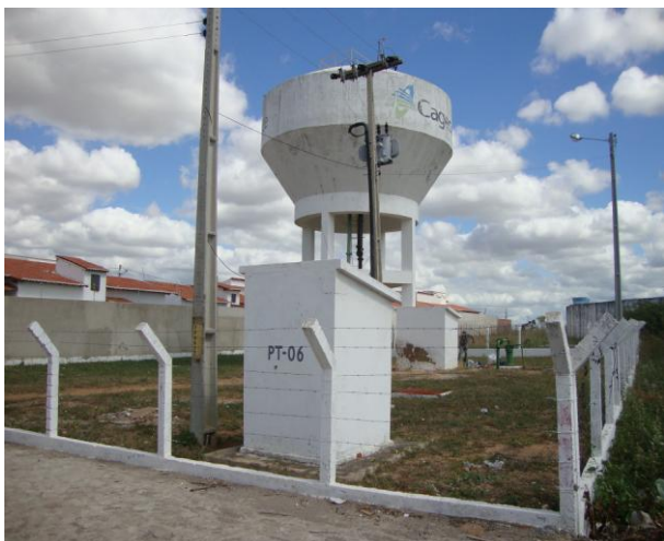
Foto 21 – Vista externa do PT-06.
