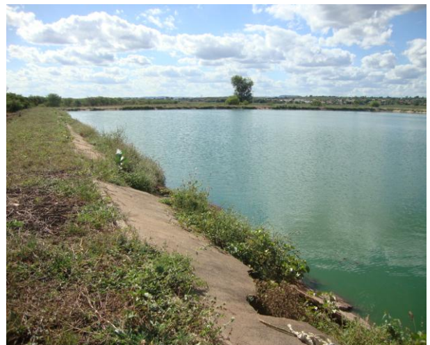
Foto 95– Vista da lagoa facultativa.
