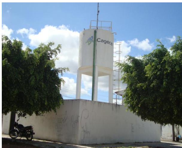
Foto 55 – Vista do REL-02.
