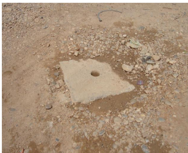
Foto 78 – Registro de descarga na Rua Padre Maranhão.
