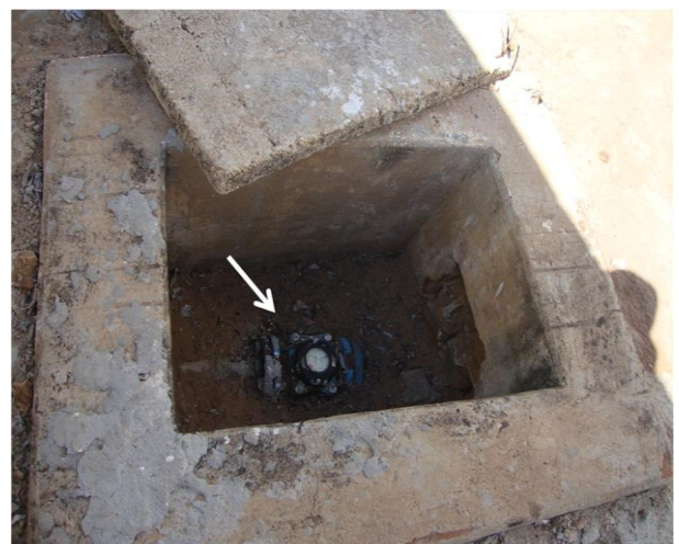
Foto 52 – Caixa de inspeção do macromedidor de água tratada na saída do PT-03.
