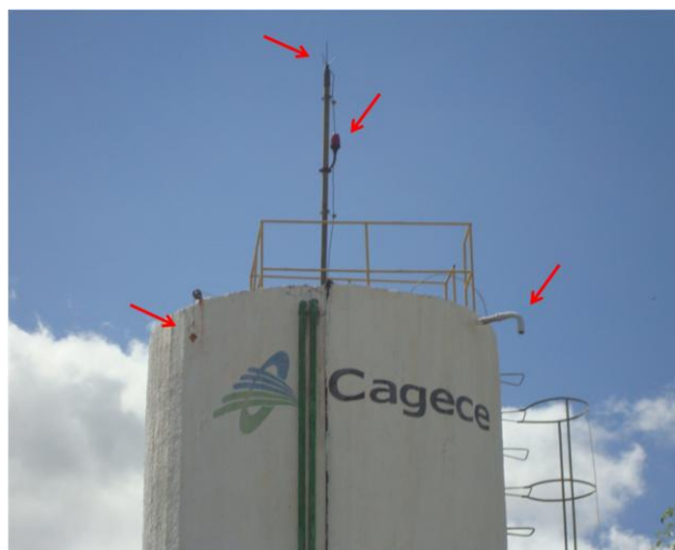
Foto 57 – REL-02: com existência de guarda-corpo na escada e na laje, para-raios, sinalizador noturno e controle de nível.
