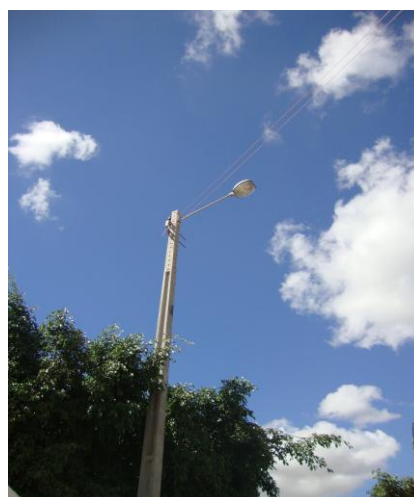
Foto 12 – Iluminação externa para trabalhos noturnos do PT-03.
