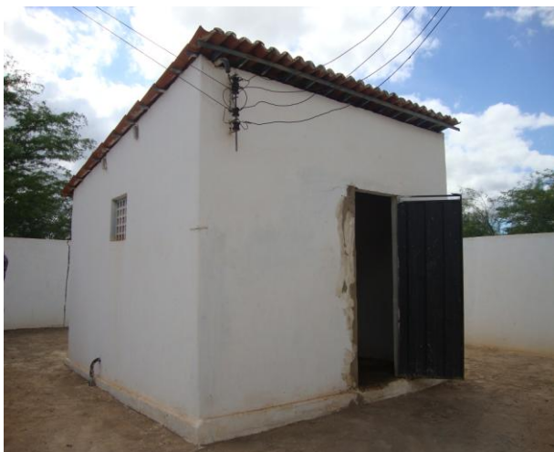
Foto 19 – Casa de abrigo do quadro de comando do PT-05.
