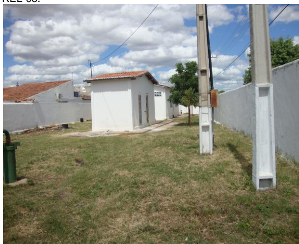
Foto 32 – Vista dos limites da unidade de tratamento.
