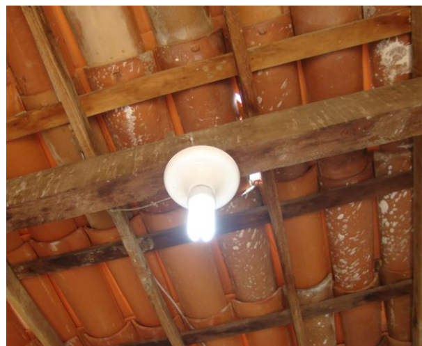
Foto 16 – PT-04 com iluminação interna.
