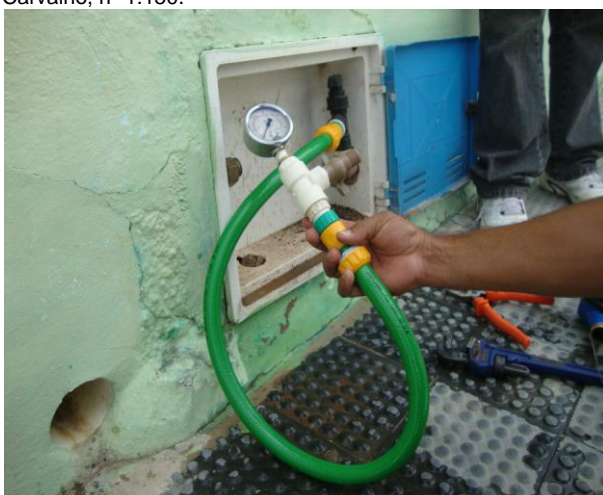
Foto 68 - Medição de pressão na Rua 2, nº 49 - Conjunto Popular.
