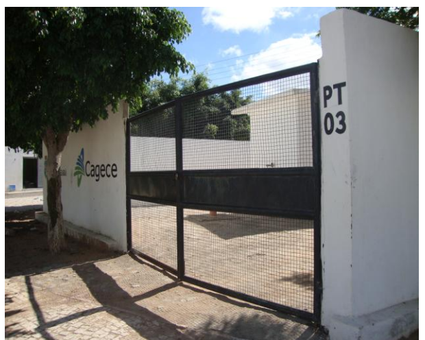
Foto 6 – Vista externa do PT-03.
