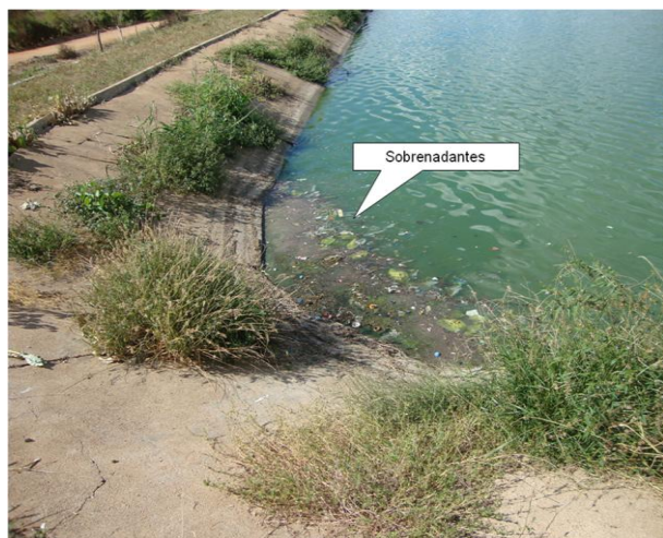
Foto 104 – Ocorrência de sobrenadante na lagoa facultativa.
