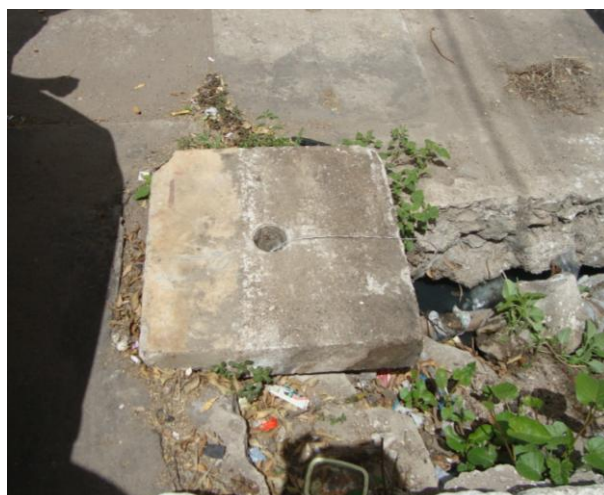
Foto 79 – Registro de descarga na Rua Marechal Floriano.
