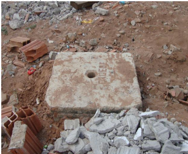
Foto 72 – Registro de descarga na Rua Bela Vista 03.
