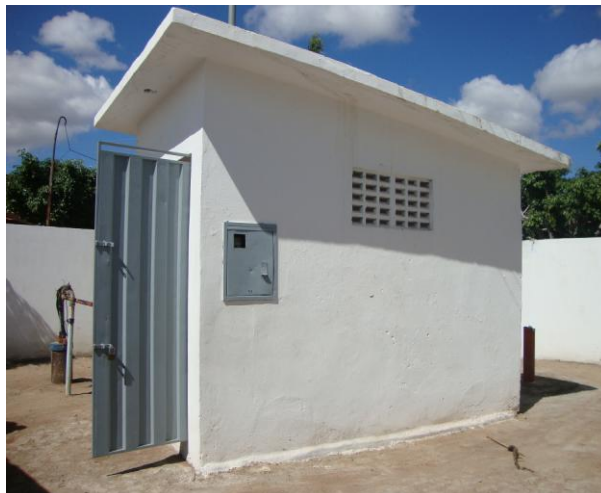
Foto 8 – Casa de abrigo do quadro de comando do PT-03.
