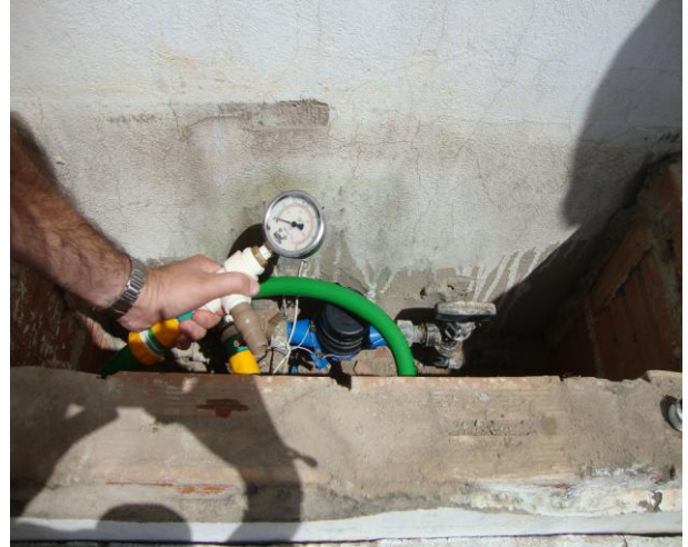
Foto 71 – Medição de pressão na Rua Vila Santana, nº 681.
