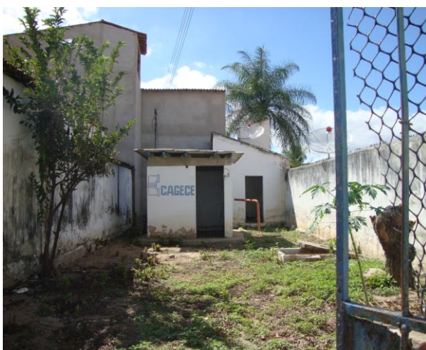
Foto 5 – Vista do PT-02 desativado.
