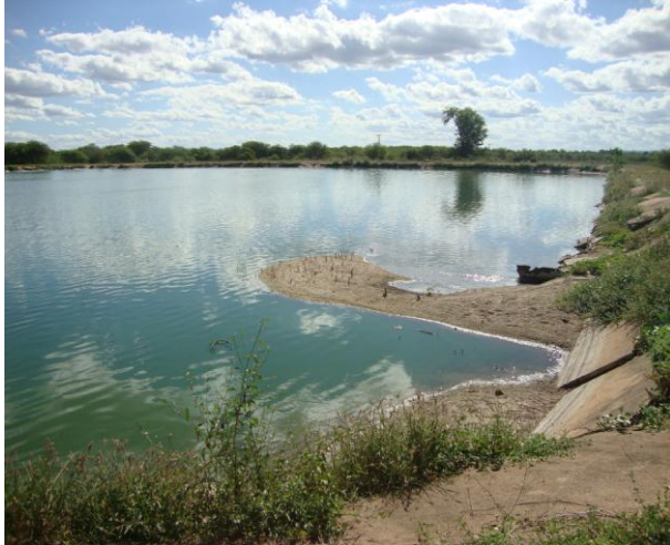
Foto 96 – Vista da lagoa facultativa.
