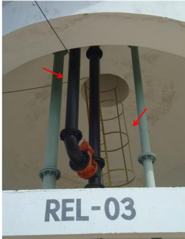
Foto 59 – REL-03: com existência de guarda-corpo na escada e tubo extravasor.
