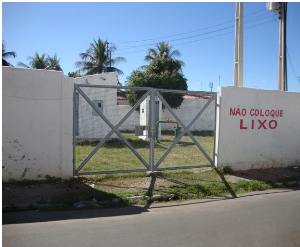
Foto 1 – Vista externa do PT-01.
