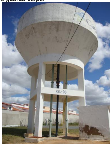
Foto 58 – Vista do REL-03.
