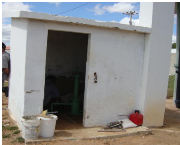
Foto 30 – Casa do clorador de pastilhas, localizada na área do REL-03.
