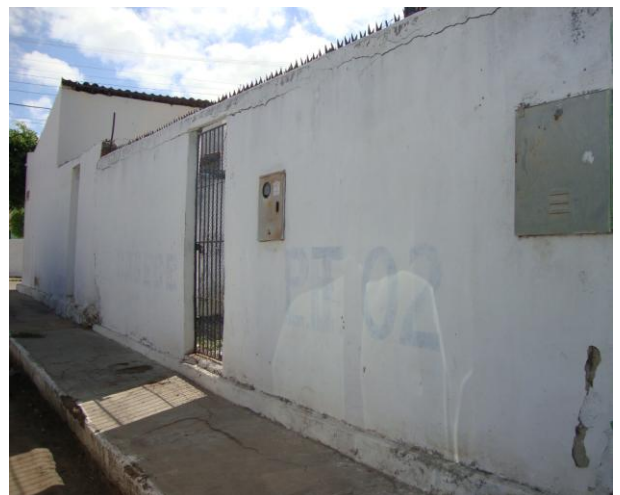
Foto 4 – Vista externa do PT-02 desativado.
