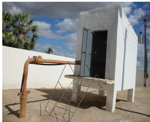
Foto 14 – Vista externa do PT-04.
