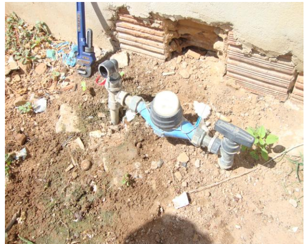
Foto 67 - Medição de pressão na Rua 4 de João Mangabeira - Bela Vista, nº 35.
