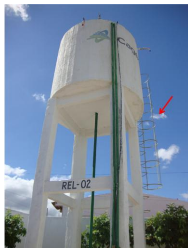
Foto 56 – Vista do REL-02 com escada e guarda-corpo.
