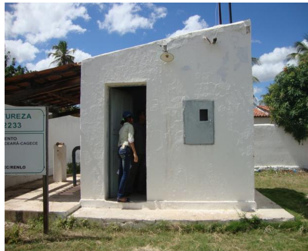
Foto 37 – Vista externa do almoxarifado de produtos químicos.
