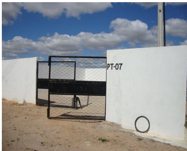
Foto 25 – Vista externa do PT-07.
