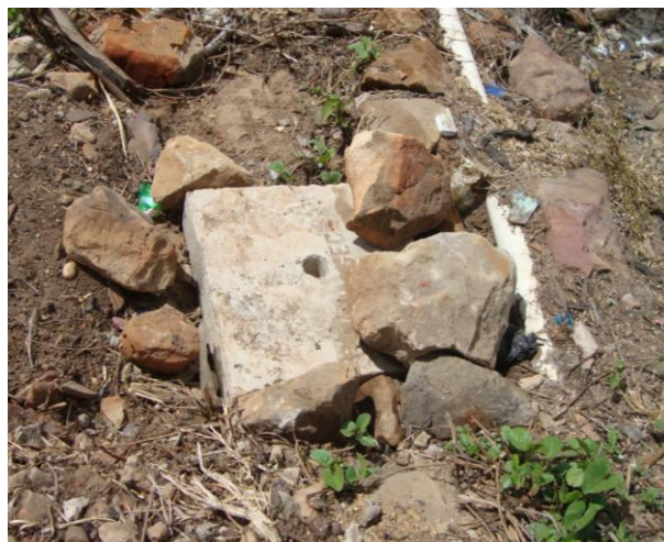
Foto 77 – Registro de descarga na Rua Bela Vista 01.
