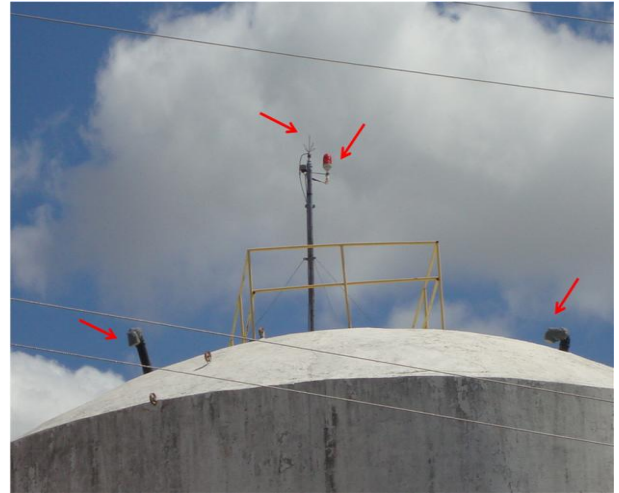
Foto 62 – REL-03: com existência de guarda-corpo na escada, para-raios e sinalizador noturno.
