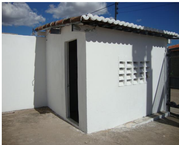
Foto 88 – EEE: casa de comando e abrigo de materiais.
