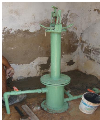
Foto 31 – Clorador de pastilha: linha de alimentação do REL-03.
