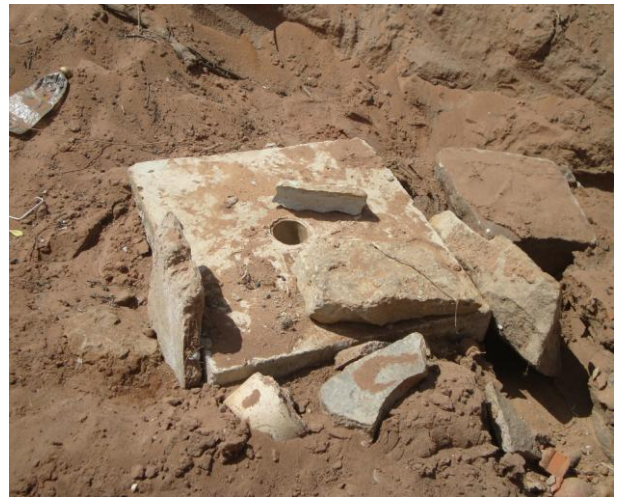
Foto 73 – Registro de descarga na Rua Bela Vista 04.
