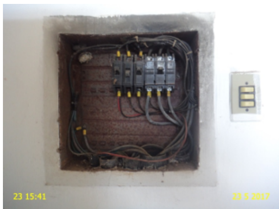
Foto 14 - EEE-02: quadro dos disjuntores sem tampa.
