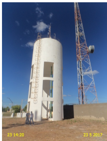
Foto 10 - REL-01: instalação de aterramento do pára-raios sem proteção.
