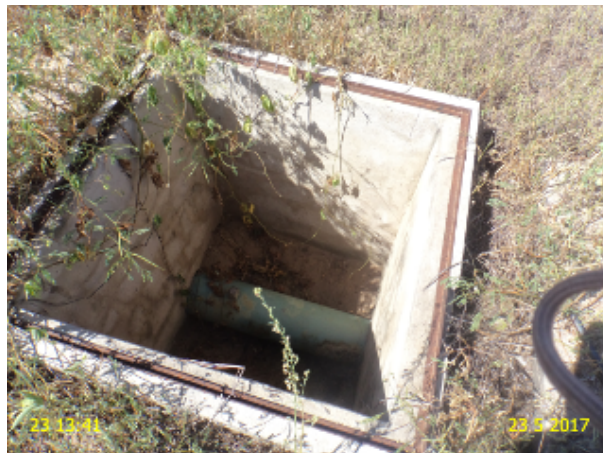
Foto 21 - Na adutora de água bruta há uma caixa de estação pitométrica sem tampa ou grade de proteção.
