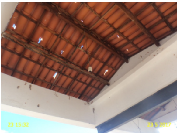
Foto 12 - EEE-01: ausência de lâmpada na área do poço de sucção.
