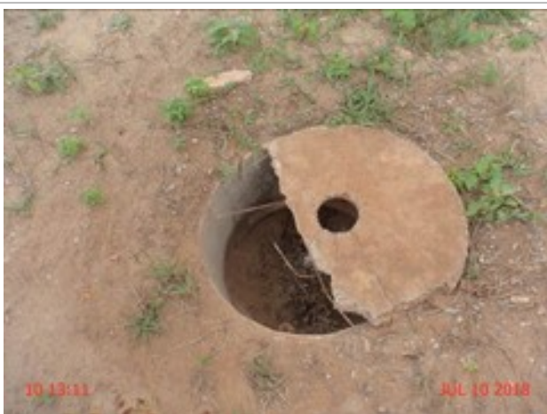
Foto 3 – Reservatório (Sede): A tampa da caixa do macromedidor do reservatório REL-23 está danificada.
