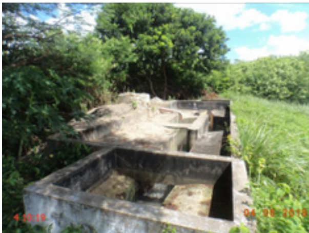
Foto 6 – ETE (Lagoinha): leito de secagem em local de difícil acesso para retirada de material.
