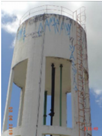
Foto 31 – REL-01 (Lagoinha): pintura deteriorada.
