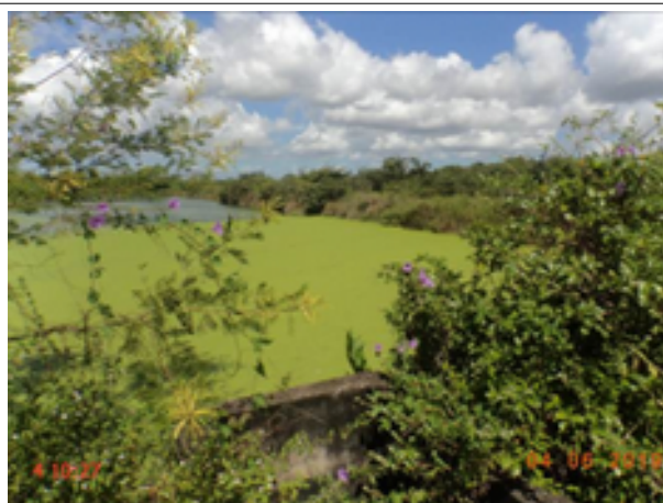
Foto 20 – ETE (Lagoinha): lagoa de maturação LM2.
