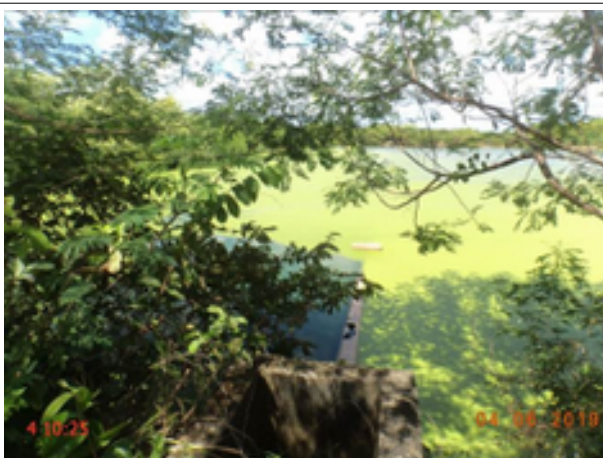
Foto 19 – ETE (Lagoinha): lagoa de maturação LM1.
