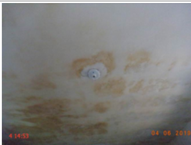
Foto 41 – ETA/Casa de química (Sede): ausência de lâmpada no almoxarifado de produtos químicos.
