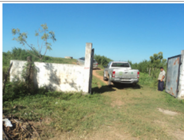
Foto 10 – ETE (Sede): muro com rachaduras e pintura deteriorada.
