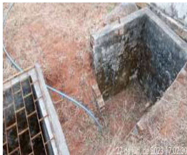
Foto 52 - RAP-07: caixa tampa.
