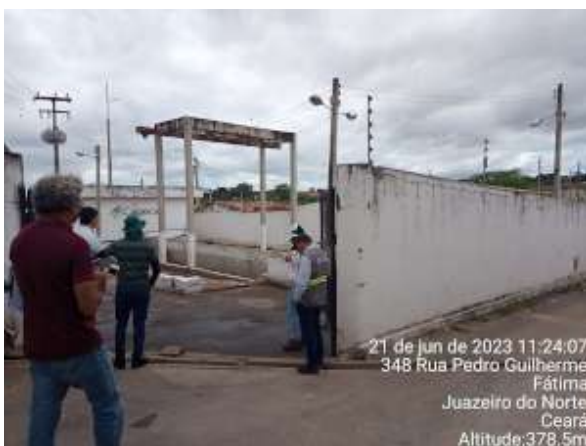
Foto 113 - EEE (Vila de Fátima): não possui identificação.
