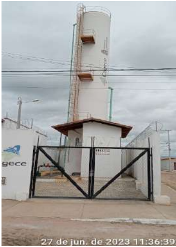
Foto 103 - REL-22 - ausência de identificação.
