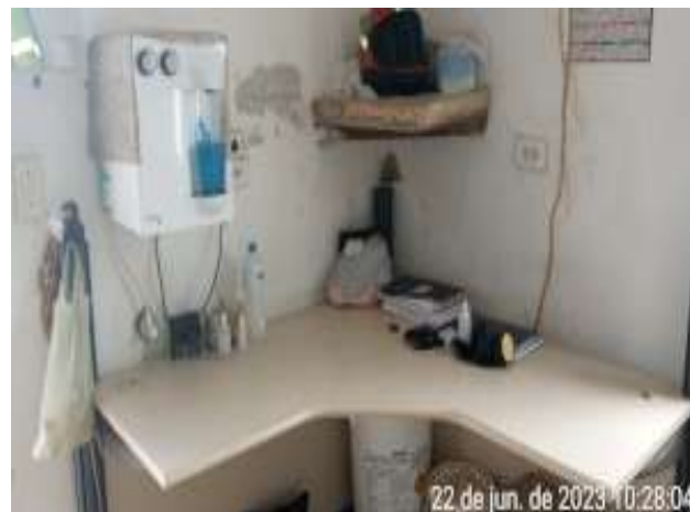
Foto 2 - RAP-05: casa de apoio dos operadores está com pintura deteriorada.
