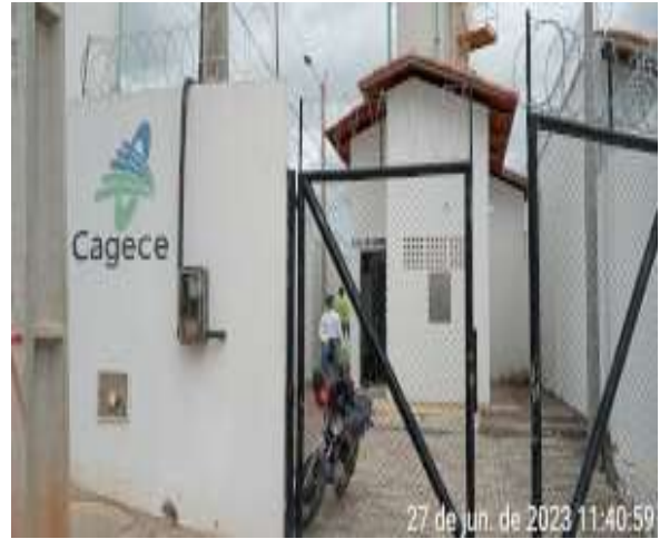
Foto 104 - EEAT-23/RAP-37/REL-23 - ausência de identificação dos reservatórios e elevatória.
