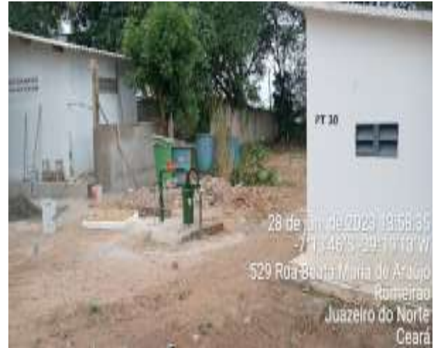
Foto 64 - PT-29/PT-30: entulhos na área do entorno do poço e caixas danificadas na área de carregamento de carro pipa.
