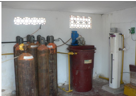
Foto 04 – casa de química.
