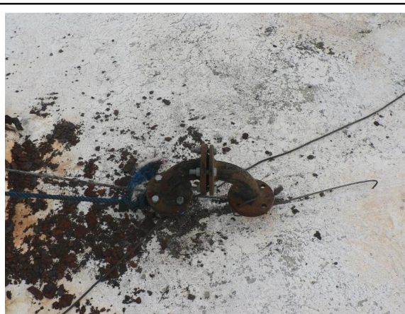
Foto 08 – REL-01: Tubulação de ventilação adequada.
