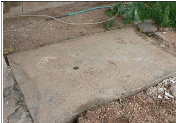
Foto 12 – Registro de descarga localizado na rua Raimundo Feitosa.
