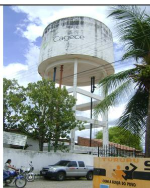
**Foto 6** – REL-02: ausência de identificação e pintura deteriorada.
