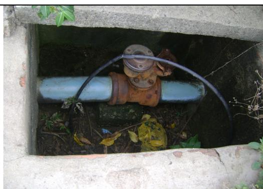
**Foto 21** – AAT: caixa da ventosa sem tampa e com tubulação preta para utilização de água.
