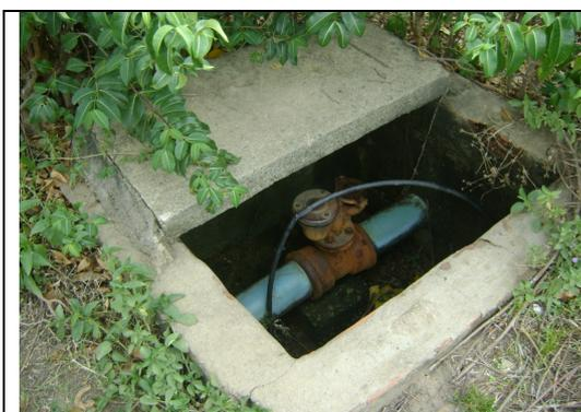
**Foto 20** – AAT: caixa da ventosa sem tampa e com tubulação preta para utilização de água.
