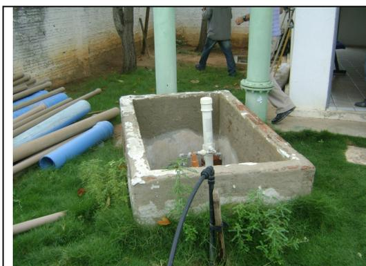
**Foto 11** – REL-02: caixa de proteção do clorador de pastilha (desativado), sem tampa.
