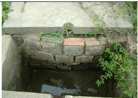
**Foto 19** – AAT: caixa de proteção do registro de descarga, aberta e danificada.
