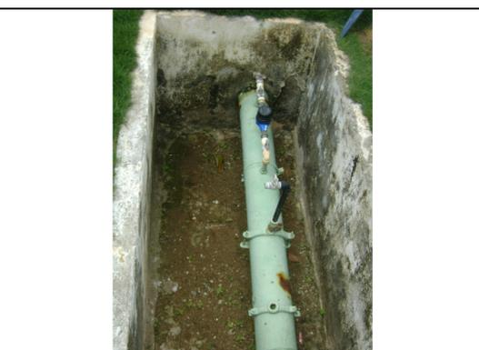
**Foto 12** – REL-02: caixa de proteção do macromedidor e da estação pitométrica, sem tampa.
