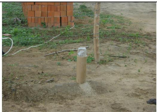
**Foto 32** – RDA: registro de descarga, sem caixa, localizado na Rua Santa Terezinha, no final da rua – Terra Prometida.
