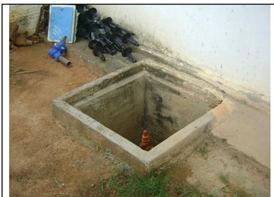
**Foto 13** – REL-02: caixa de proteção do registro da distribuição, sem tampa.
