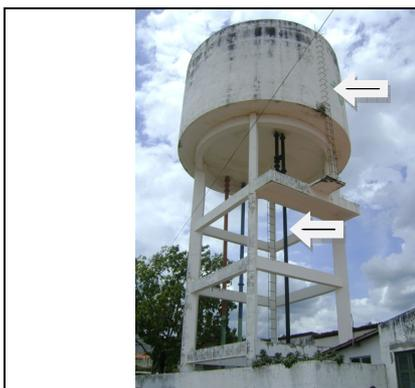
**Foto 7** – REL-02: escada de acesso externo em más condições de uso e sem gaiola protetora.
