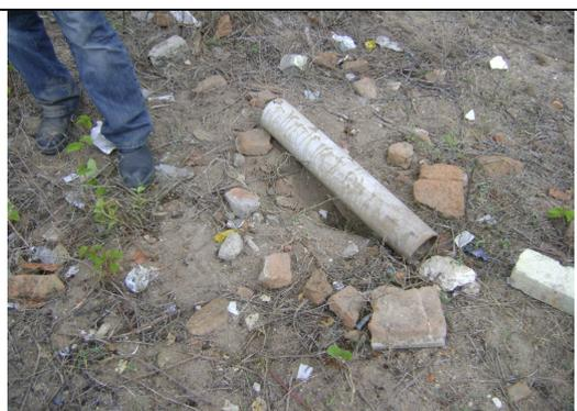
**Foto 34** – RDA: registro de descarga, com cano quebrado, localizado ao lado do Centro Educacional Patrícia Mota de Freitas – estrada para Mulungu – Novo Horizonte.
