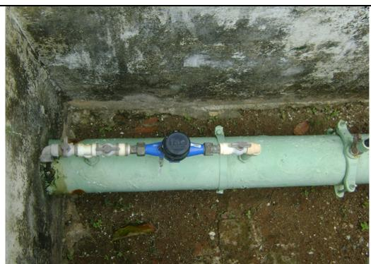
**Foto 15** – REL-02: macromedidor proporcional e estação pitométrica.
