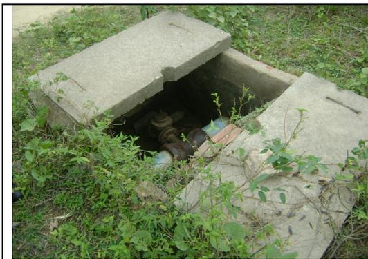
**Foto 18** – AAT: caixa de proteção do registro de descarga, aberta e danificada.
