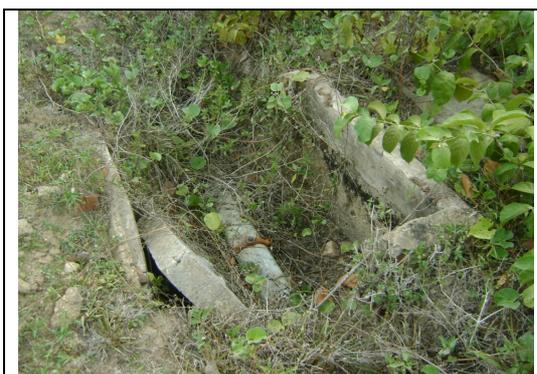
**Foto 22** – AAT: caixa de proteção da tubulação, danificada e sem tampa.
