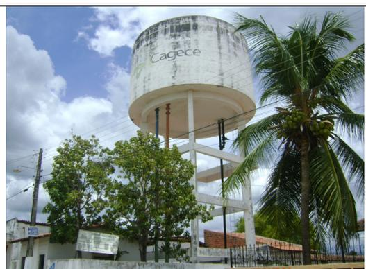
**Foto 8** – REL-02: sem guarda corpo na laje de cobertura.
