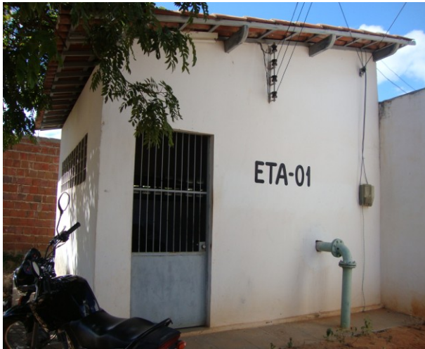
Foto 24 – Vista externa da elevatória EE-01.
