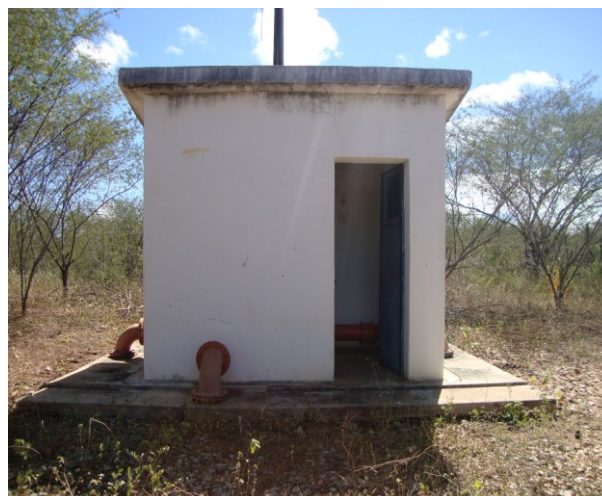
Foto 6 – Vista da casa de abrigo do quadro de comando do PT-02.
