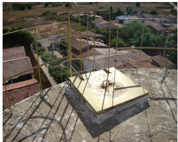
Foto 34 – REL-01: tampa de inspeção em adequada condição de vedação..
