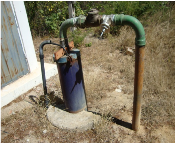
Foto 1 – Vista externa do poço PT-01.
