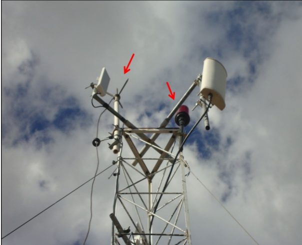
Foto 35 – REL-01: com existência de para-raios e sinalização noturna.
