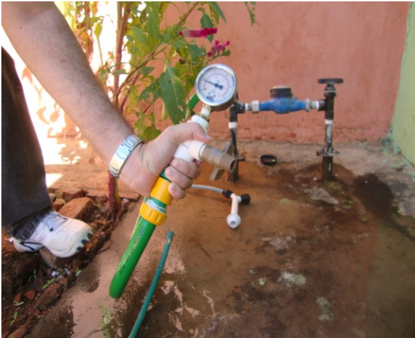
Foto 40 – Medição de pressão instantânea na Rua João Barbosa, nº 30.
