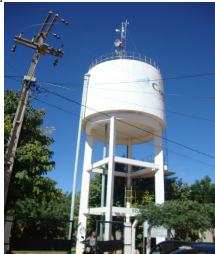
Foto 32 – Vista do REL-01.
