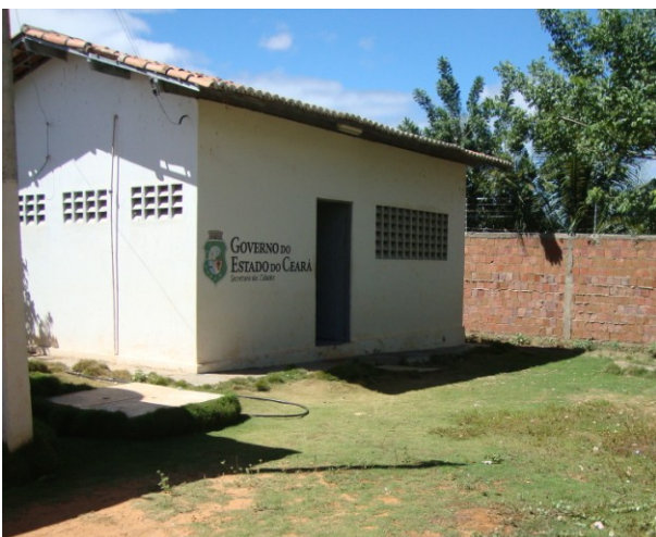
Foto 44 – Vista externa do escritório/loja de atendimento ao usuário.
