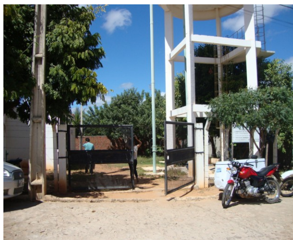
Foto 10 – Vista externa da ETA.
