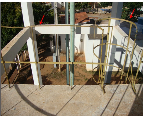
Foto 33 – Vista do REL-01 com guarda-corpo na escada e na laje de acesso.
