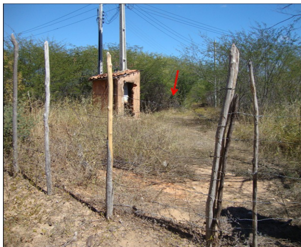
Foto 8 – Entrada dos poços PT-01 e PT-02, sem facilidade de acesso.
