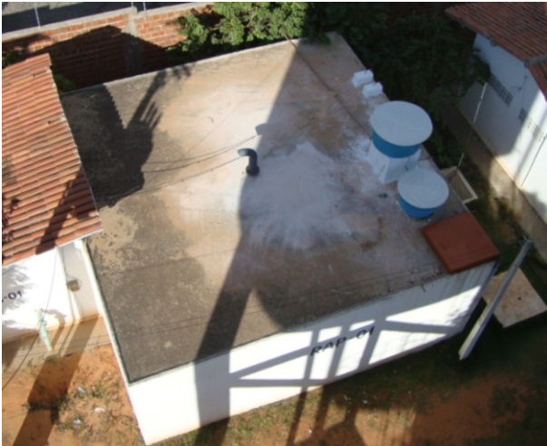
Foto 29 – Cobertura do RAP-01.
