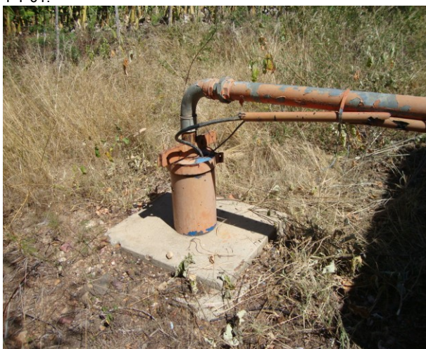
Foto 5 – Vista do poço PT-02.
