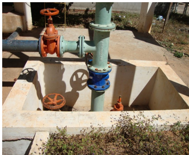
Foto 21 – Caixa de proteção dos registros na adutora de água tratada no interior da ETA.
