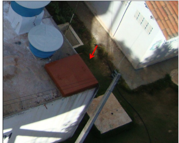
Foto 30 – RAP-01: tampa de inspeção em adequada condição de vedação.
