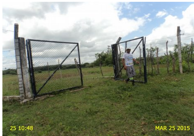
Foto 16 – ETE: sem placa de identificação.
