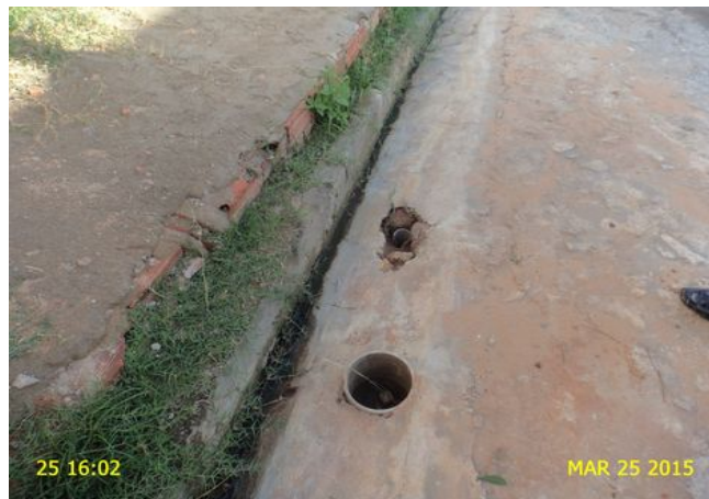
Foto 22 - RDA: registro de descarga sem caixa localizado na Rua Francisco Pereira Lima.
