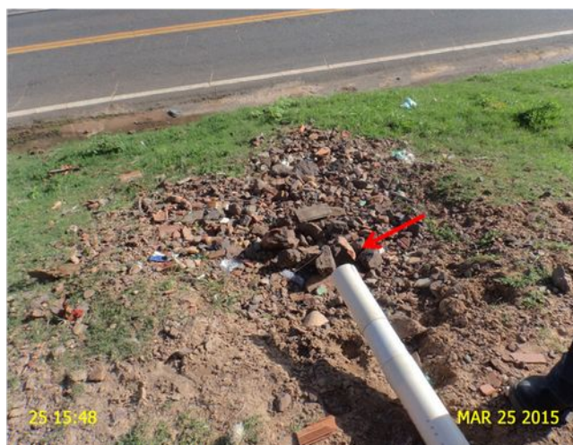
Foto 35 – RAP-03: tubo extravasador.
