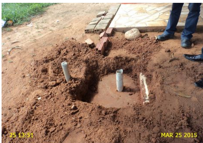
Foto 19 - RDA: registro de descarga sem caixa localizado na Av. Francisco Agapito Tavares Ribeiro.
