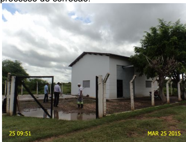
Foto 11 – EEE-01: sem identificação.
