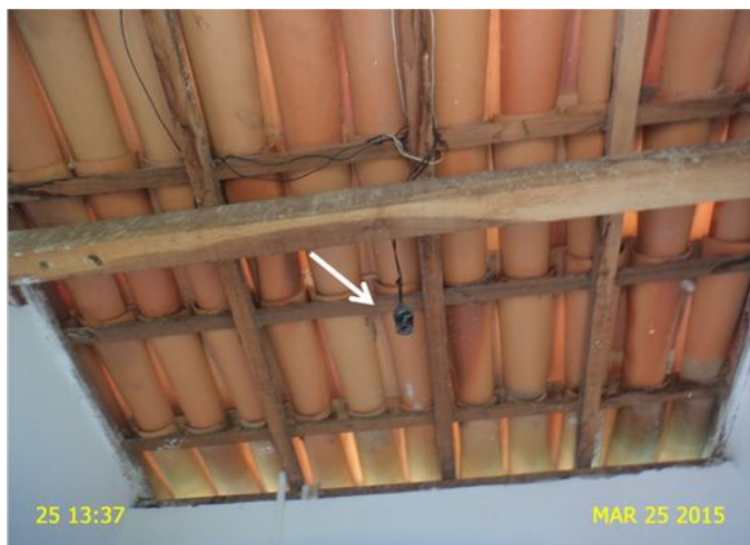
Foto 1 – PT-02: sem iluminação para trabalhos noturnos.
