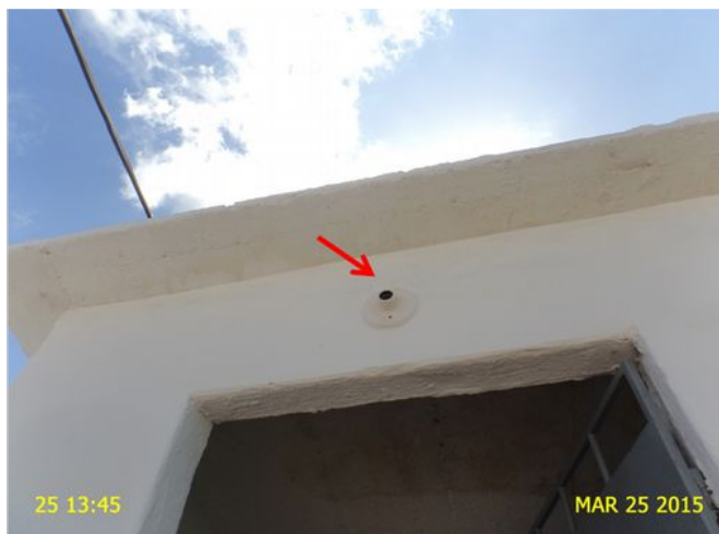
Foto 2 – PT-04: sem iluminação para trabalhos noturnos.
