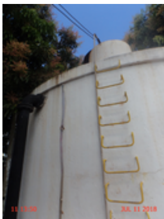
Foto 11 – Reservatórios: A escada de acesso do RAP-01 está sem o apoio para acessar a laje de cobertura.
