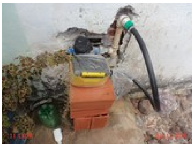
Foto 2 – RDA: Datalogger instalado no endereço Rua Alto do gravatá SN.
