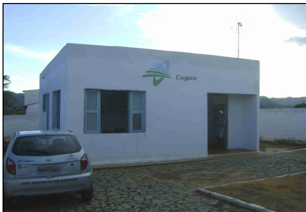
Foto 25 – Vista externa do escritório da CAGECE.
