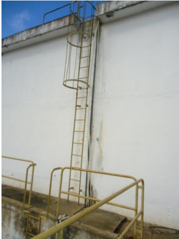
Foto 17 – RAP-08: escada de acesso.
