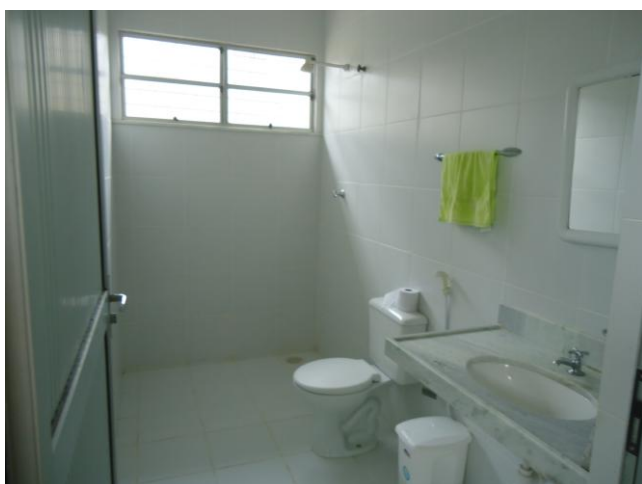
Foto 44 – Loja de Atendimento: instalações sanitárias.
