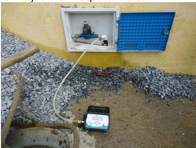
Foto 32 – Medição instantânea de pressão na Rua Luis Cunha, 385 – Monte Castelo (Creche).
