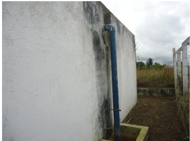
Foto 14 – RAP-07 (Jaburuna): tubo extravasor.
