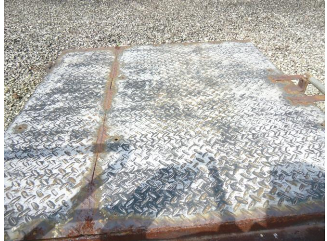
Foto 20 – RAP-08: Tampa de inspeção.
