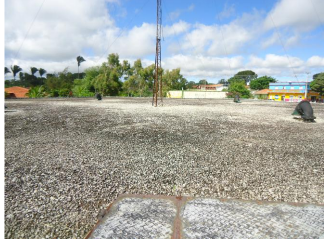
Foto 18 – RAP-08: laje de cobertura.
