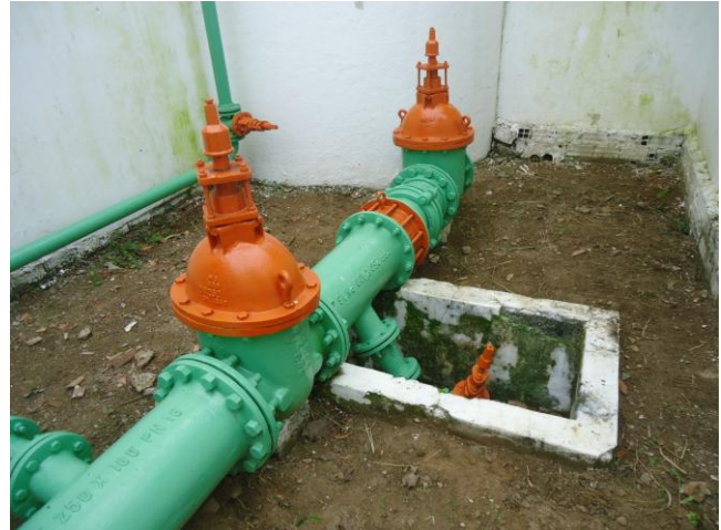
Foto 02 – TAU 09 : Entrada de água.
