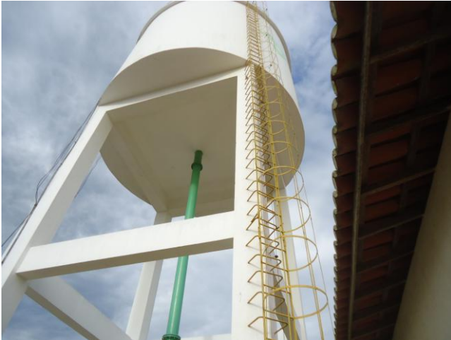
Foto 25 – REL-10: escada de acesso.
