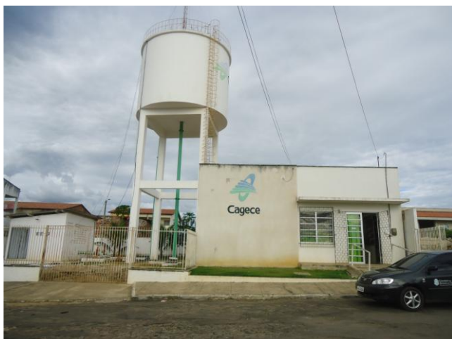
Foto 40 – Loja de Atendimento: vista externa.
