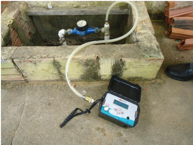
Foto 30 – Medição instantânea de pressão na Rua Projetada 01 – Cajueiro da Jaburuna.
