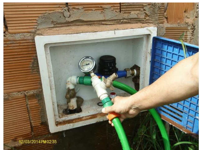
Foto 17 – Medição de pressão na Av. Joaquim Sousa Lima, s/n.
