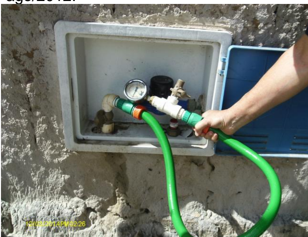
Foto 16 – Medição de pressão na Rua João do Nascimento, nº 64 (SMS).
