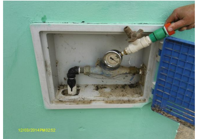
Foto 19 – Medição de pressão na Rua Joaquim Lino, nº 33 (SMS).
