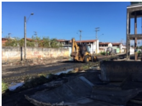
Foto 4 – ETE - Araturi: pátio da ETE, remoção de rejeitos.
