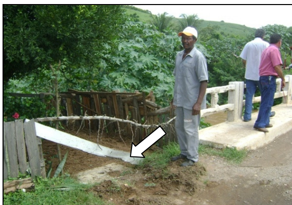
Foto 24 – Registro de descarga, av. José Humberto Alcântara Gondim (c/ caixa).
