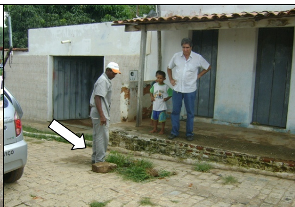
Foto 25 – Registro de descarga, av. José Humberto Alcântara Gondim (s/ caixa).
