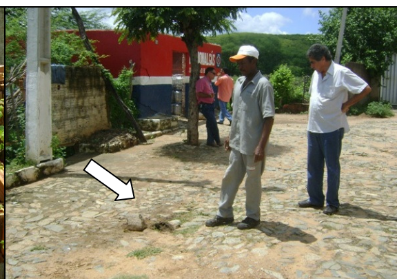
Foto 27 – Registro de descarga, rua Sabino Pereira (s/ caixa).
