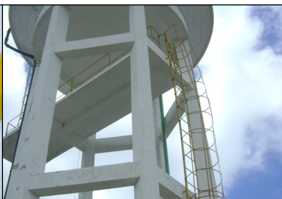
Foto 17 – Escada do REL-01.
