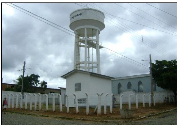
Foto 7 – Vista da ETA.
