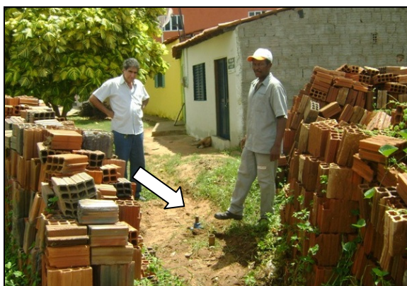
Foto 26 – Registro de descarga, rua Manuel Leobino de Sousa (s/ caixa).
