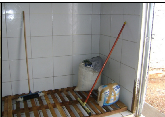
Foto 10 – Estrado de madeira na ETA.
