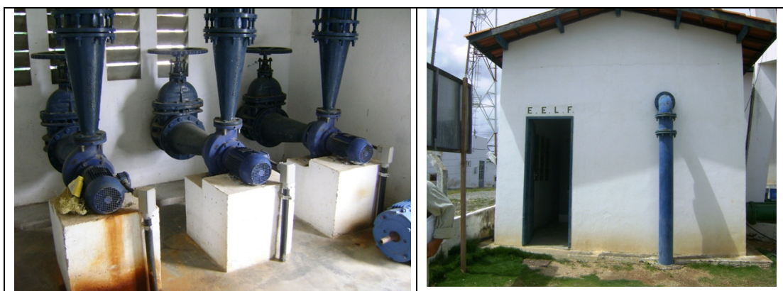
Fotos 20 e 21 – Vista da EELF-01 e a casa de proteção
