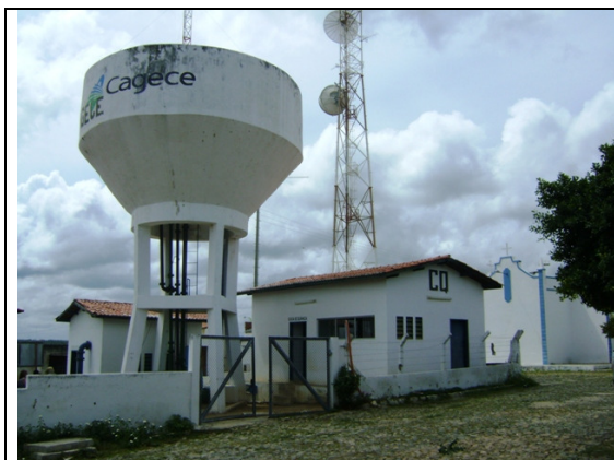
Foto 3 – Vista da entrada da ETA do SAA de Jaguaretama
