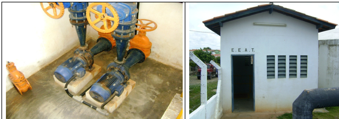
Fotos 18 e 19 – Vista da EEAT-01 e a casa de proteção
