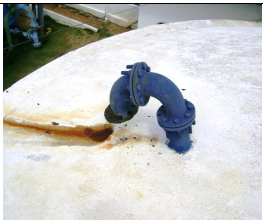
Foto 29 – RAP - 01 – tubulação de ventilação
