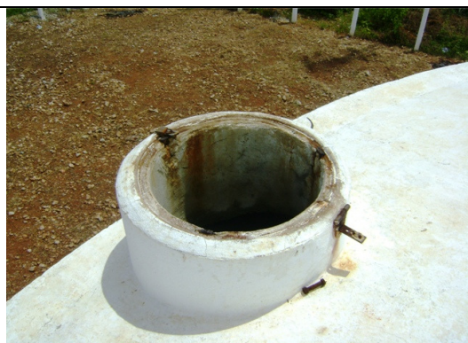
Foto 31 – RAP-02 sem tampa
