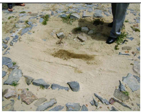
Foto 34 – Adutora de água tratada – ventosa soterrada
