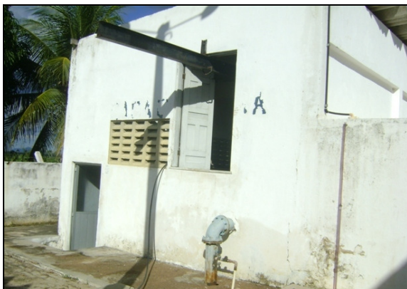
Foto 19 – Prédio de abrigo das elevatórias EECS-01, EELF-01 e da EEAT-01.
