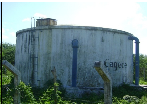
Foto 27 – Escada de acesso e inspeção do RAP-02.
