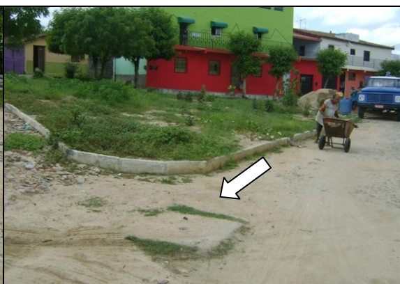
Foto 39 – Registro de descarga localizado na Rua Pedro Rodrigues Martins, Centro.
