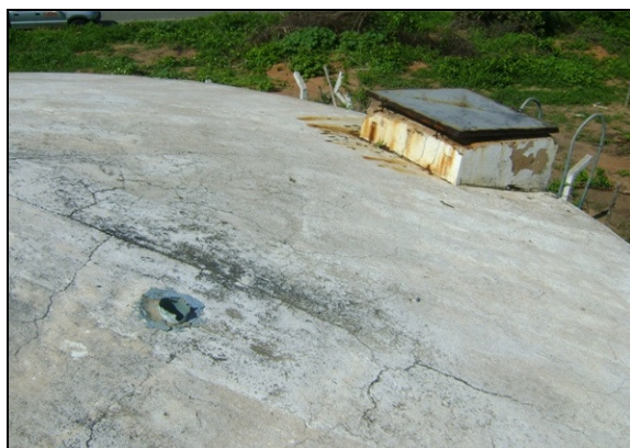
Foto 28 – Inspeção e ventilação do RAP-02..
