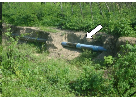
Foto 34 – Macromedidor de água tratada na entrada do REL-01.
