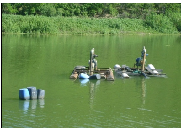
Foto 17 – Elevatória EECS-01 de Reriutaba e EECS-01 de Varjota.
