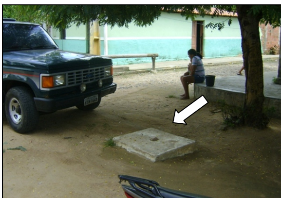
Foto 42 – Registro de descarga localizado na Rua Pedro Rodrigues Martins, Centro.
