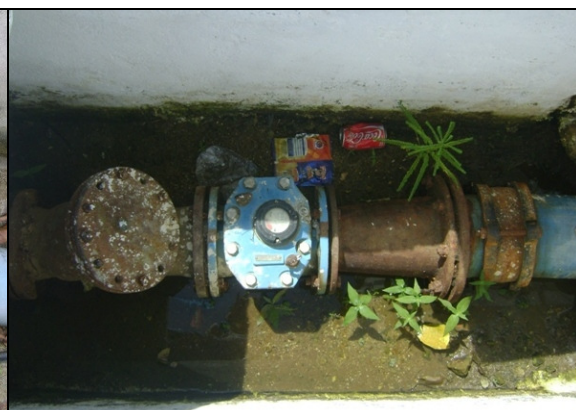
Foto 34 – Macromedidor de água tratada na entrada do REL-01.
