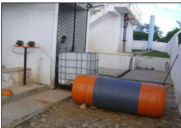
Foto 8 – Cilindros e dosador de cloro gasoso.
