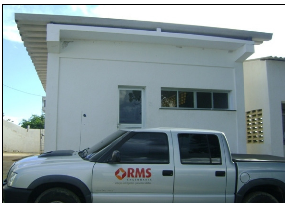
Foto 4 – Vista da casa de química.
