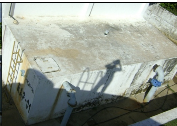
Foto 25 – Inspeção e ventilação do RAP-01.
