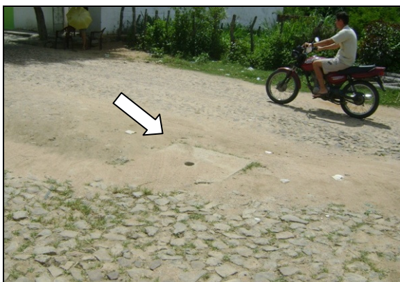
Foto 38 – Registro de descarga localizado na Tv. São José, Centro.
