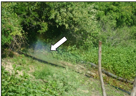
Foto 32 – Vazamento na adutora de água bruta próximo à entrada da ETA.
