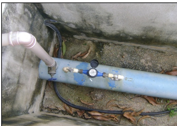
Foto 33 – Medidor proporcional de água tratada na saída da ETA.
