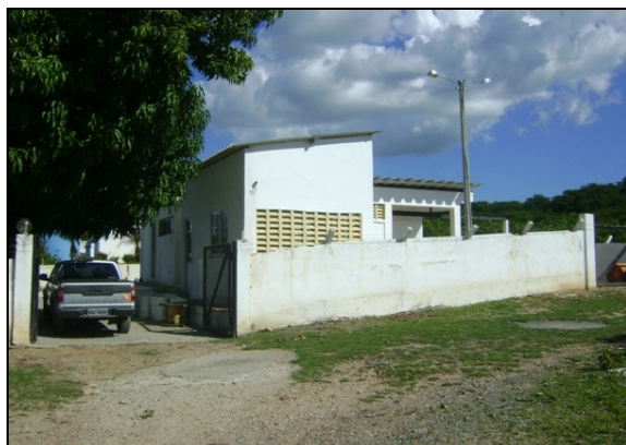
Foto 2 – Entrada da ETA.
