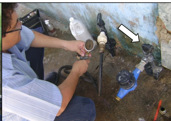
Foto 49 – Medição de pressão no Conjunto Nova Esperança, FNS 170 - Carão, sem hidrômetro.
