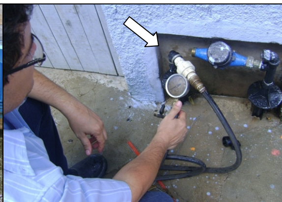
Foto 47 – Medição de pressão na Rua José Antônio de Melo, FNS 342 - Vila Nova, sem hidrômetro.
