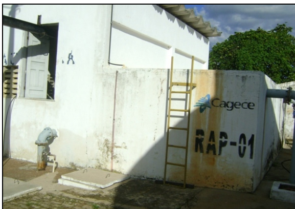
Foto 24 – Identificação e escada do RAP-01.
